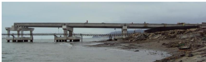
Figura 20: Vigas pretensadas en puentes
