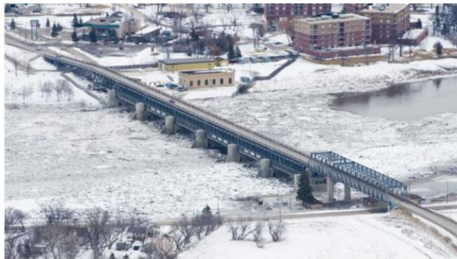
Figura 21: Acción de las palizadas y de hielo flotante en los cauces de agua sobre los puentes.
