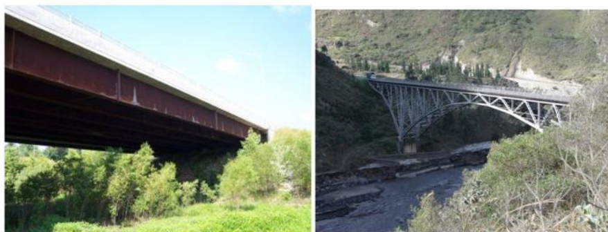
Figura 3: Puentes Estructura de Acero.
