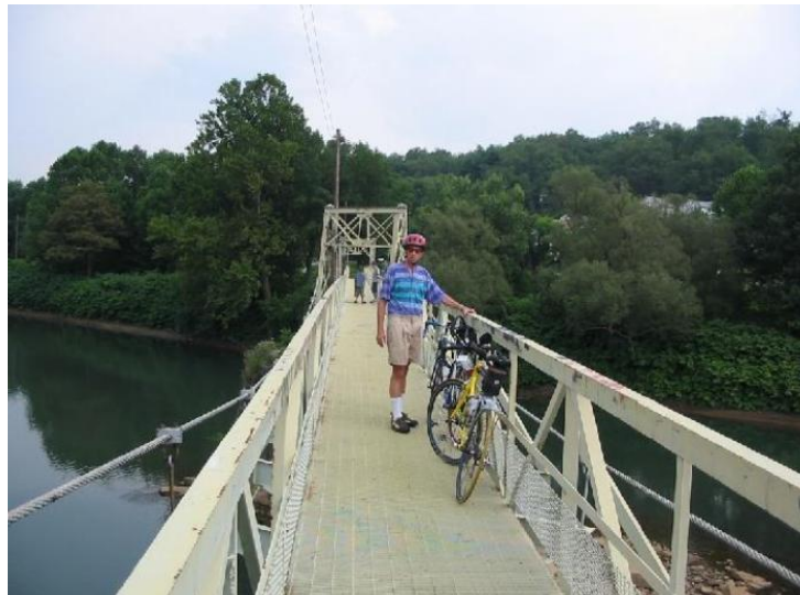
Figura 23: Puente peatonal y ciclovía
