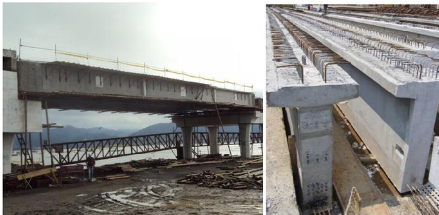
Figura 2: Vigas para Puentes Preesforzados.
