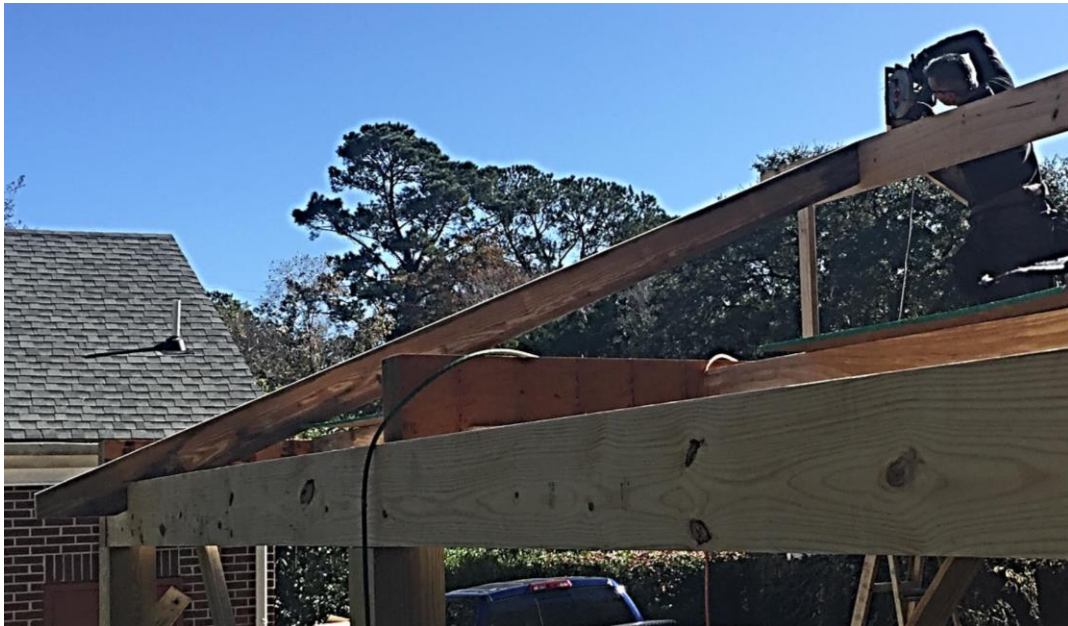
Figura 87: Colocación de vigas de techado.
