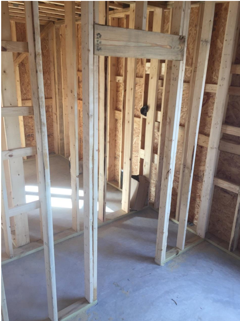
Figura 85: Enmarcado tipo de puerta.
