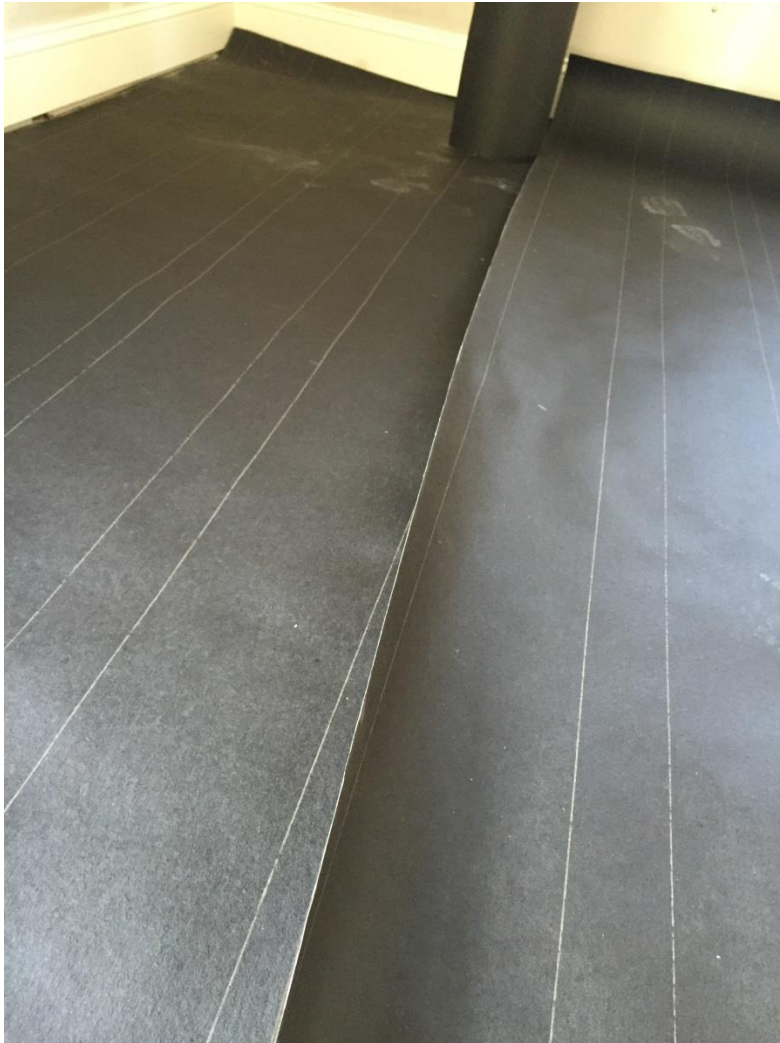
Figura 123: mastico en piso.
