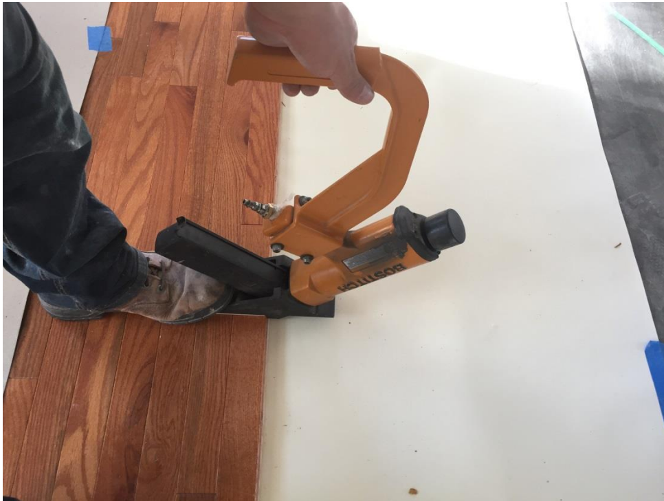
Figura 124: Colocación de piso terminado de madera.
