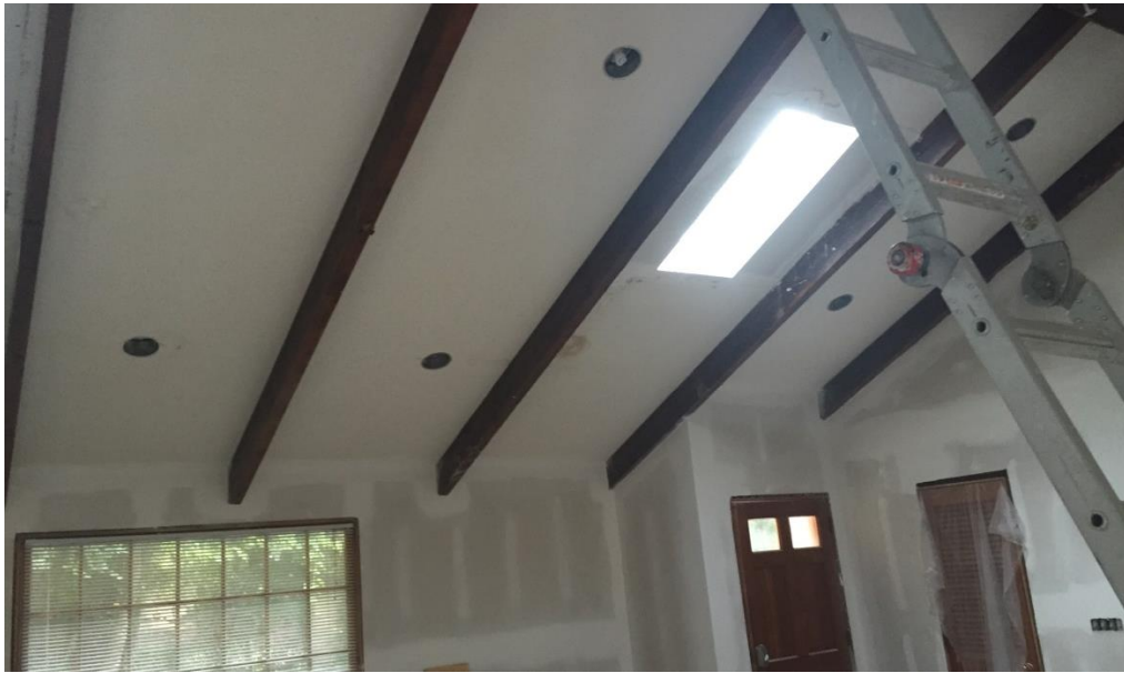
Figura 103: colocación gypsum en techado.
