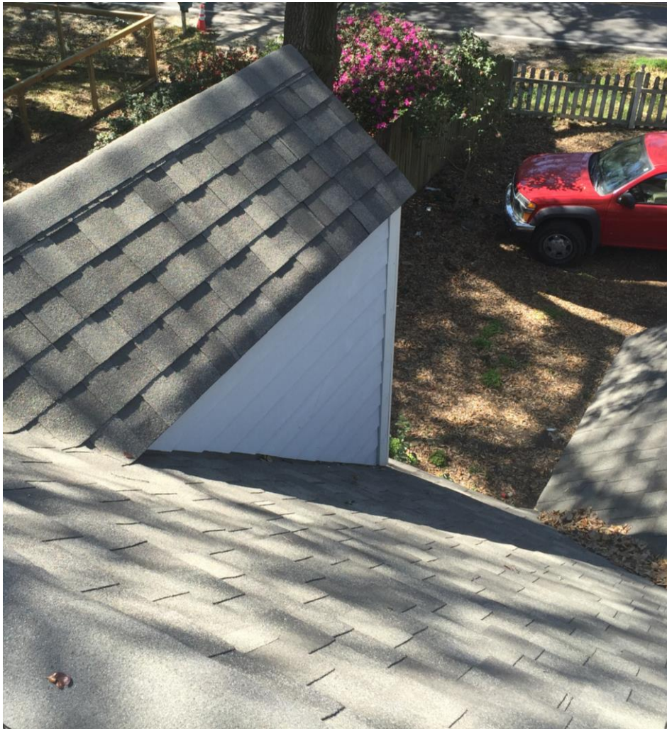
Figura 94: techado en la cima de la casa.
