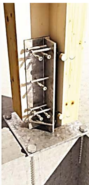
Figura 75: Unión columna - cimentación.
