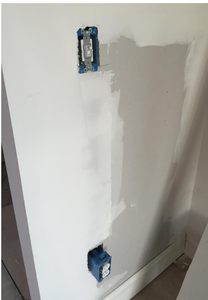
Figura 113: Aberturas en gypsum para las instalaciones eléctricas
