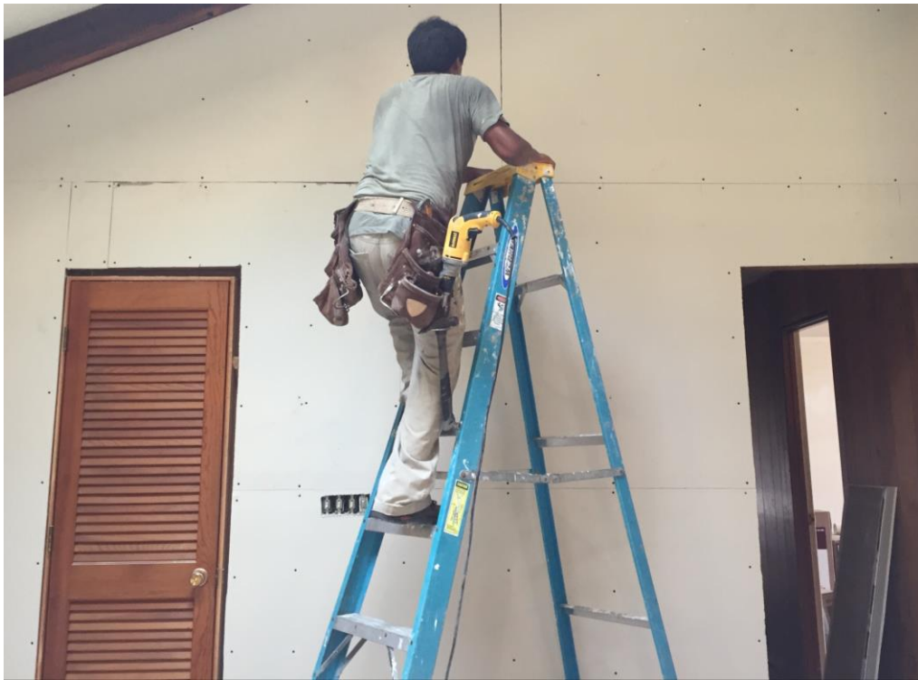
Figura 102: colocación gypsum en paredes.
