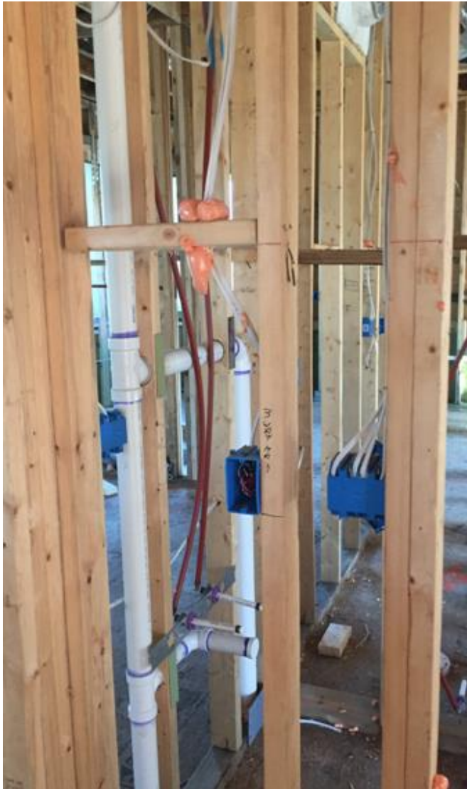
Figura 97: Instalaciones eléctricas y plomería entre parantes.
