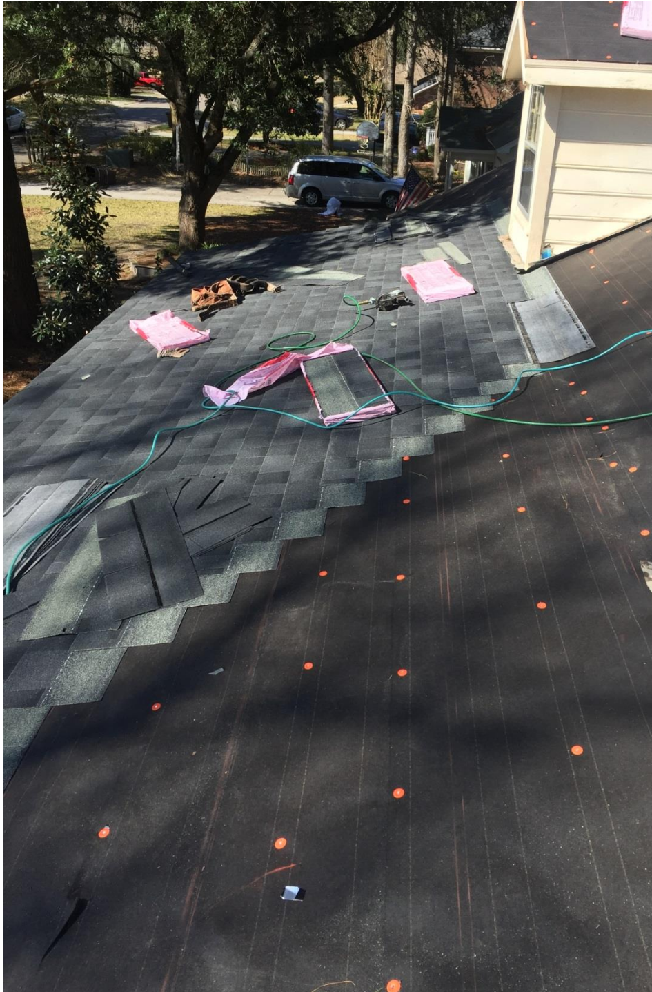
Figura 93: Proceso de colocación de teja asfáltica.
