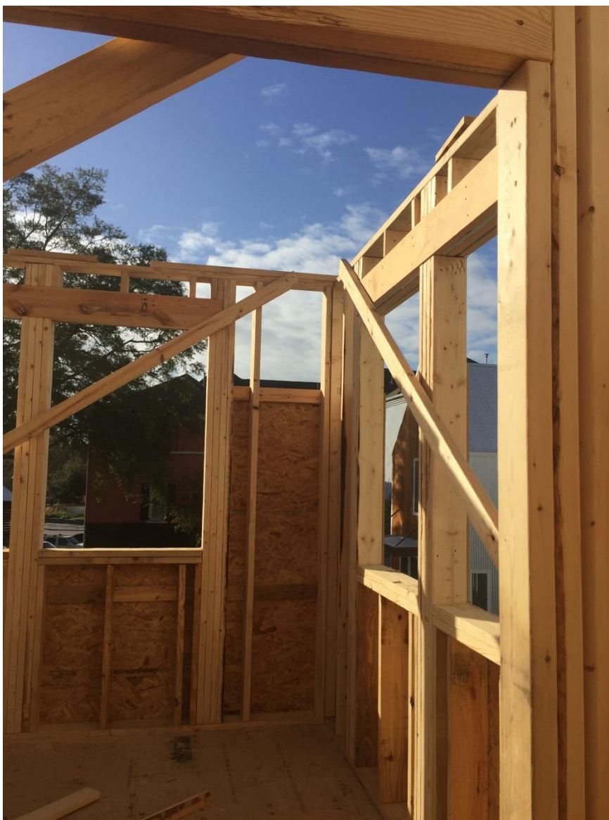
Figura 8: Madera tratada a presión con preservantes utilizada como parantes de paredes exteriores.
