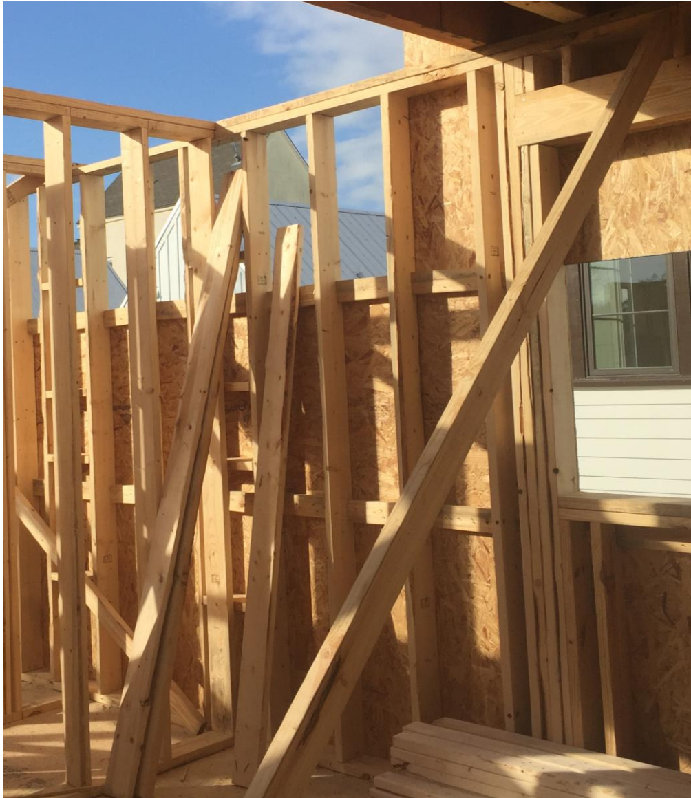
Figura 84: Enmarcado de paredes exteriores e interiores.
