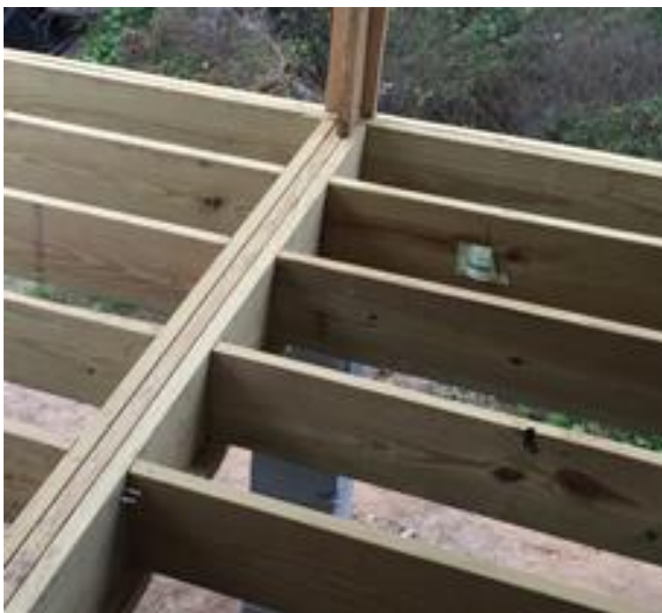
Figura 81: Viguetas de piso descubiertas.
