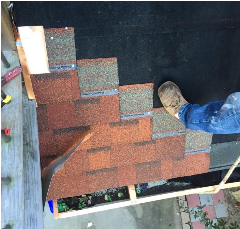
Figura 91: Colocación de primeras tejas asfálticas.
