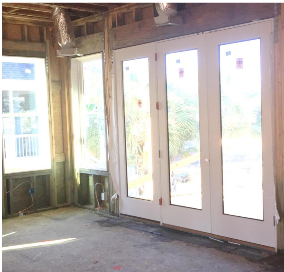
Figura 98: Colocación de Puertas y ventanas.
