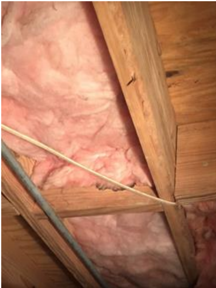
Figura 100: Insulación colocada entre viguetas.
