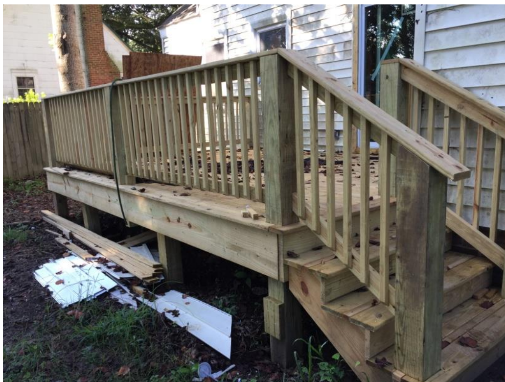
Figura 9: Madera tratada a presión con preservantes utilizada como estructura de un balcón exterior.
