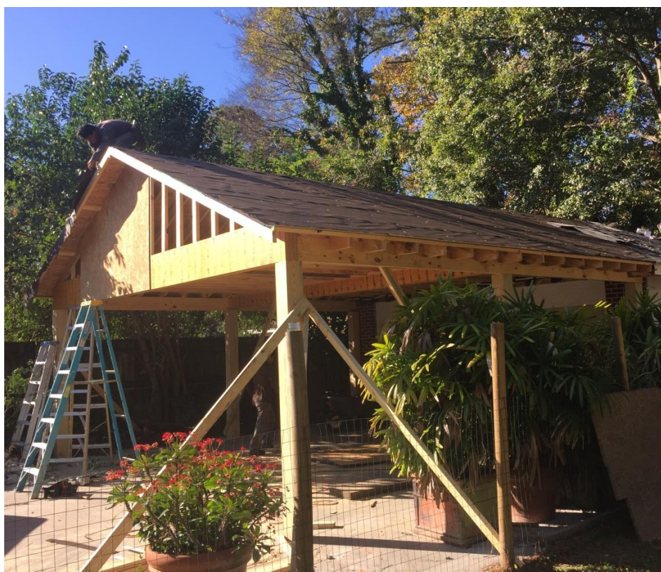
Figura 127: Proceso constructivo de casas de madera en estados unidos.
