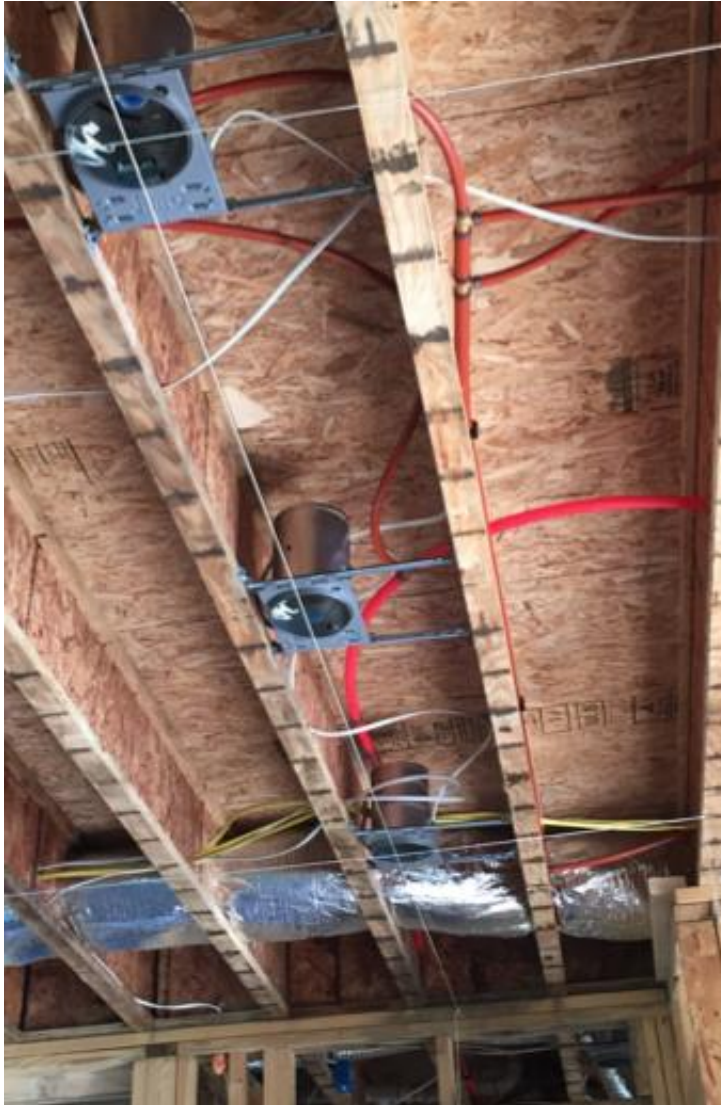
Figura 96: Instalaciones eléctricas, aire acondicionado.
