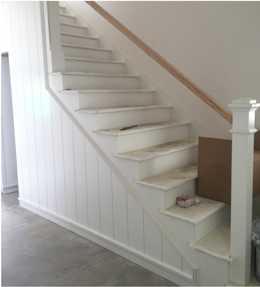
Figura 116: Recubrimiento del enmarcado de escaleras
