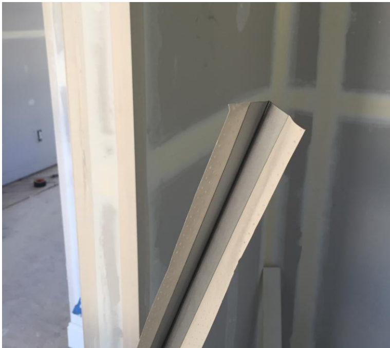
Figura 104: colocación de papel rígido en juntas.
