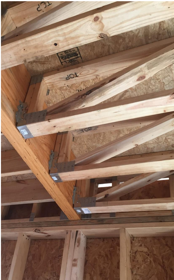
Figura 80: Otras placas de conexión para vigas.
