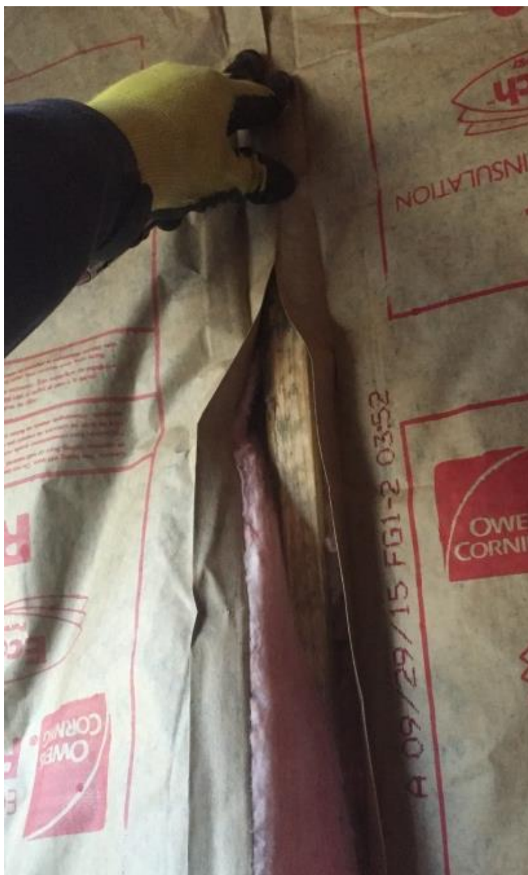
Figura 101: Insulación colocada entre parantes.
