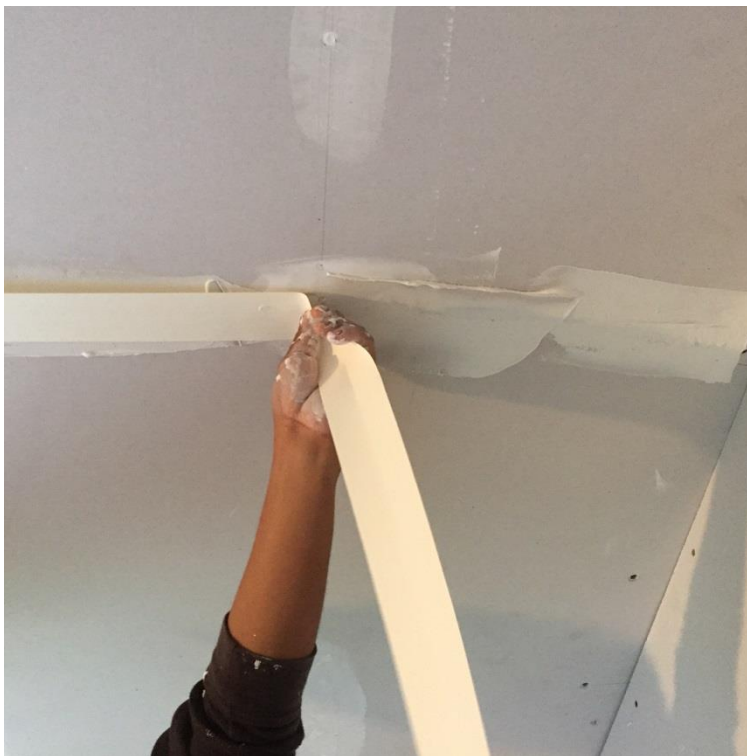
Figura 107: Colocación de cinta de papel o fibra.
