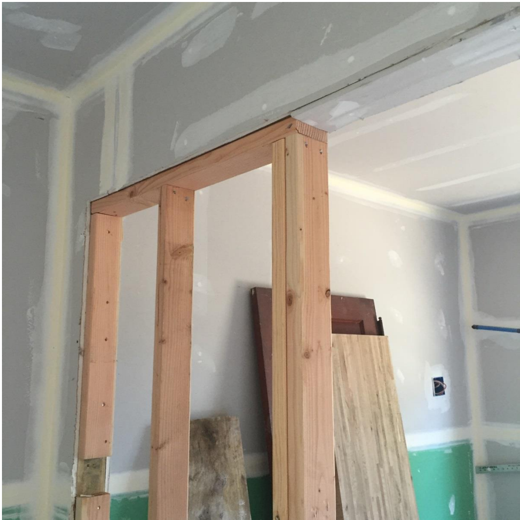
Figura 111: Sellado de agujeros y juntas de gypsum.
