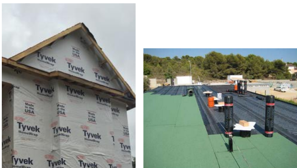
Figura 89: Lámina sintética en paredes y Lámina asfáltica en techos.
