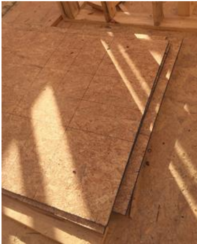
Figura 82: Viguetas de piso cubiertas con tablero contrachapado.
