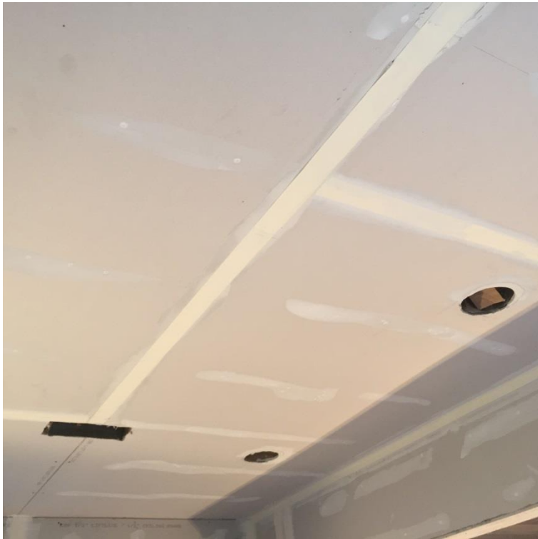
Figura 109: limpieza de superficie.
