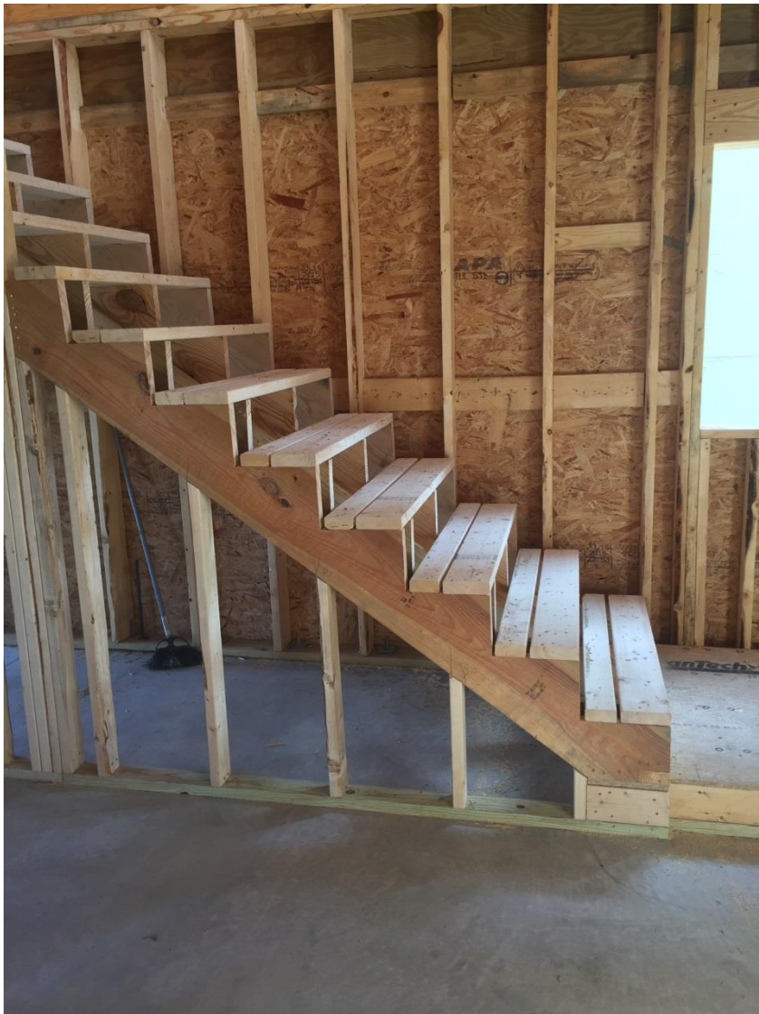
Figura 115: Enmarcado de escaleras
