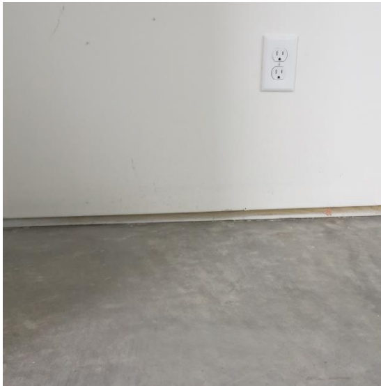
Figura 119: Ranura para piso terminado.
