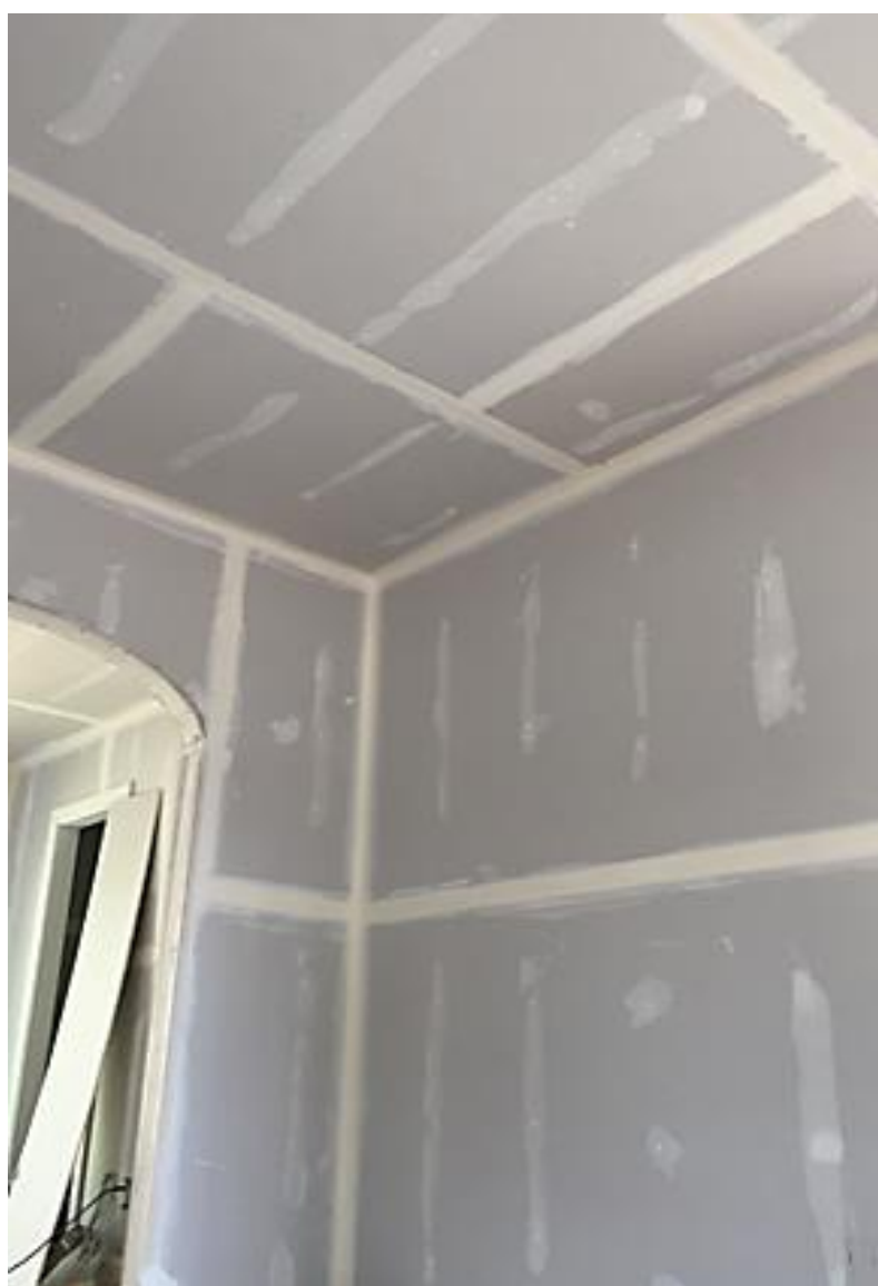
Figura 105: Sellado de agujeros y juntas de gypsum.
