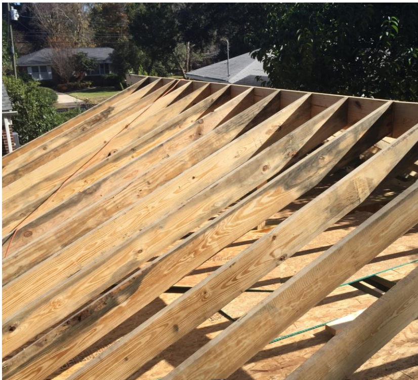
Figura 88: Entramado del Techado.
