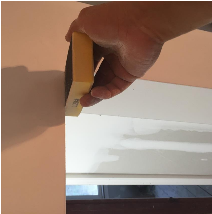
Figura 110: Lijado de paredes.
