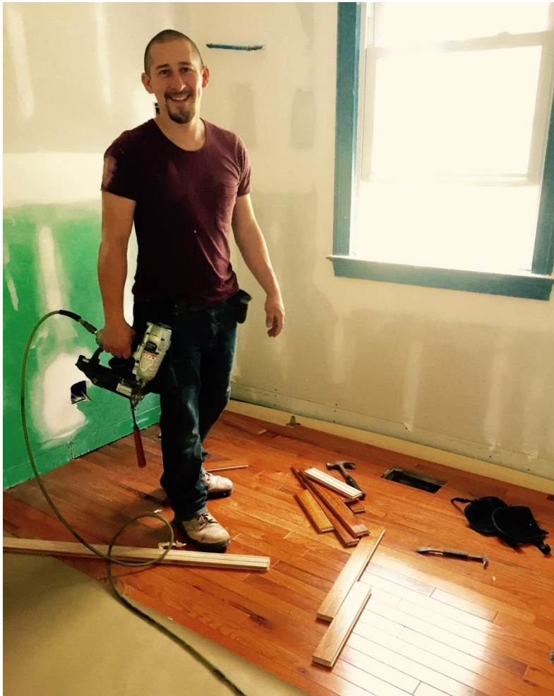
Figura 126: Clavado final del piso terminado.
