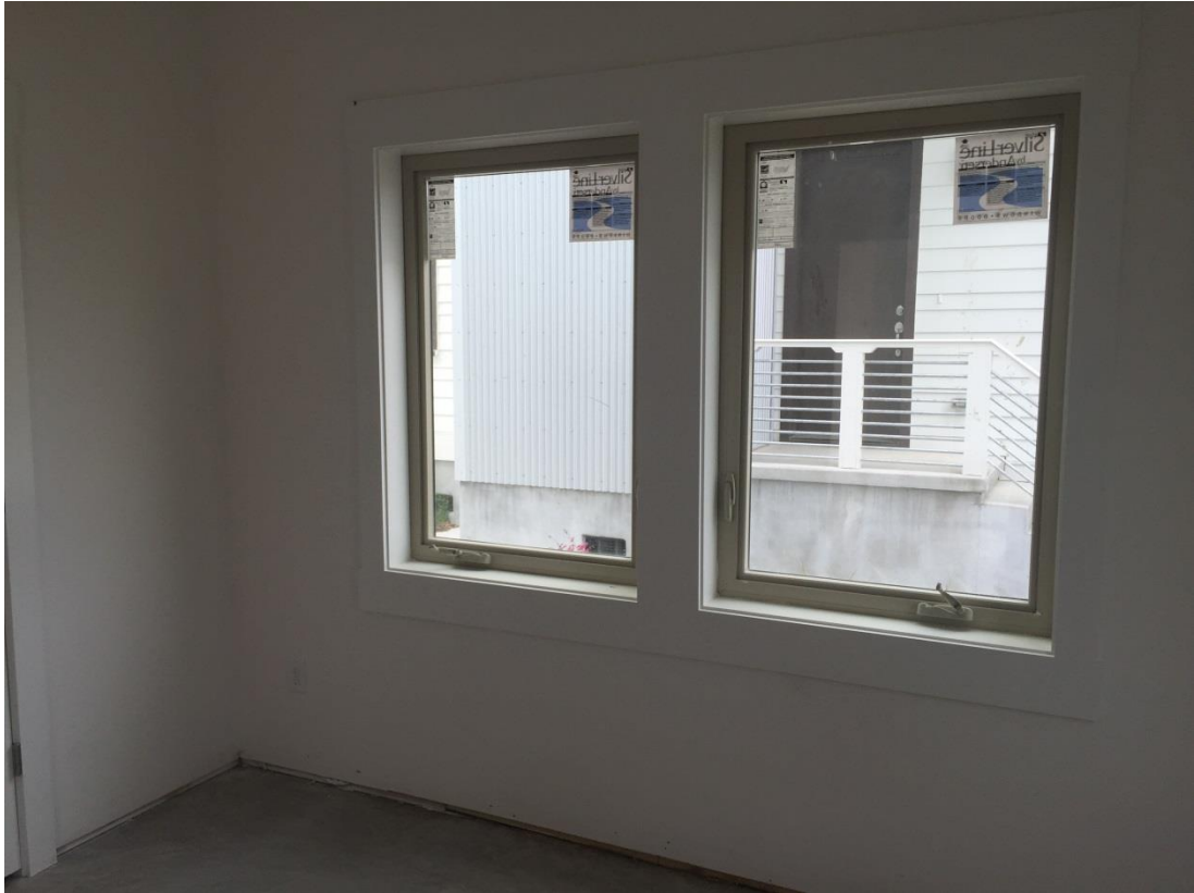
Figura 118: Recubrimiento y pintado de ventanas y aberturas.
