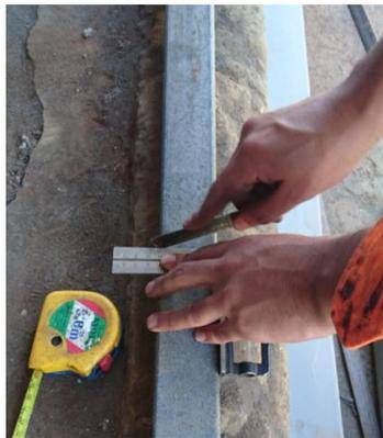
**Figura 69. Medición perfiles.**
