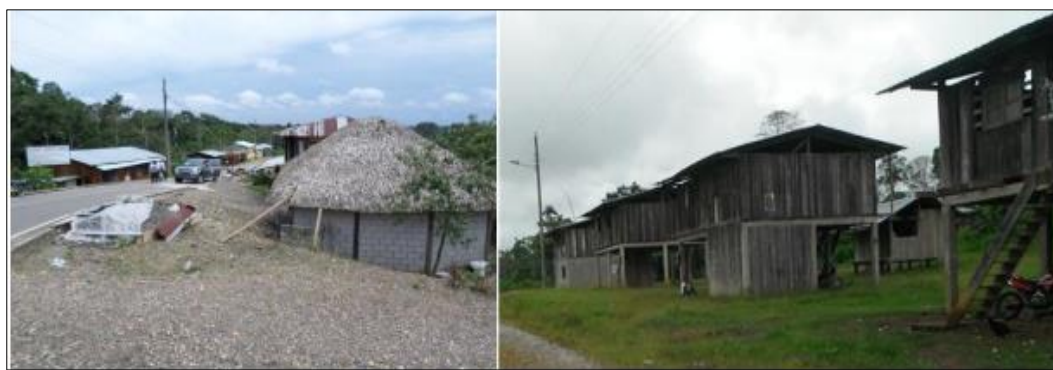
Figura 5. Viviendas de construcción mixta y madera.
