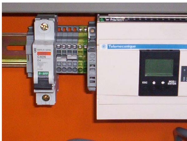
Figura 5.8 Montaje de Disyuntor, portafusible y borneras en Estación Booster I.
