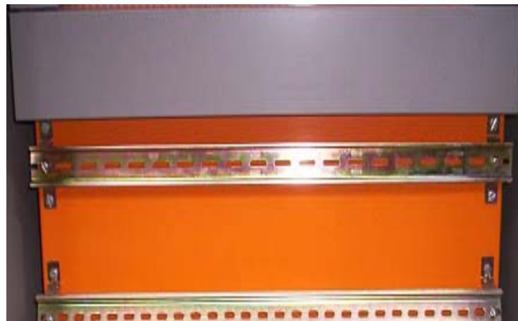
Figura 5.9 Panel SCHORCH #2 Parte Frontal Superior Estación Booster II.
