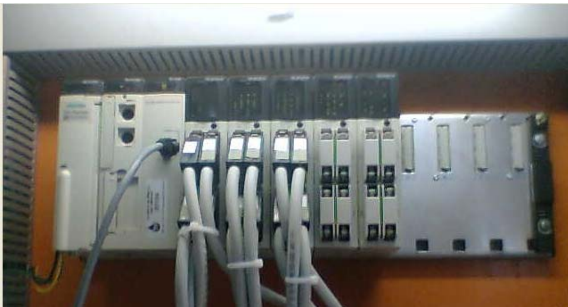
Figura 5.16 Montaje del PLC Premium 2634M en la Estación Recuperadora
