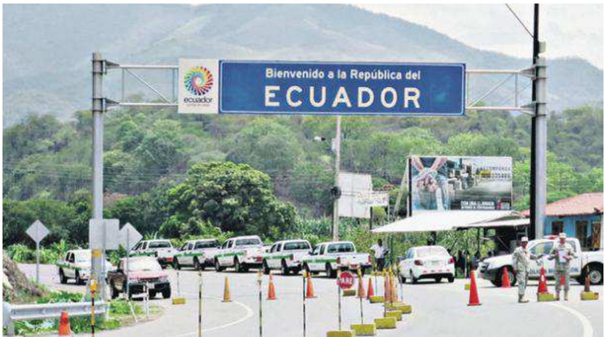
Figura 6 Puente Internacional de Macará
