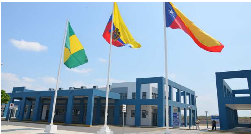
Figura 13 Centro Binacional de Atención en Frontera Huaquillas
