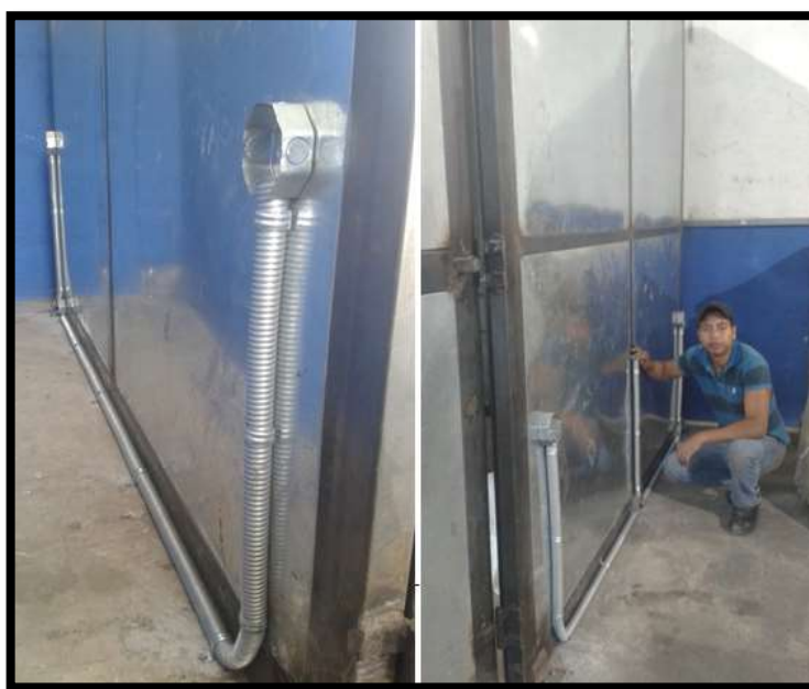
Figura 93. Instalación de tubería metálica anillada
