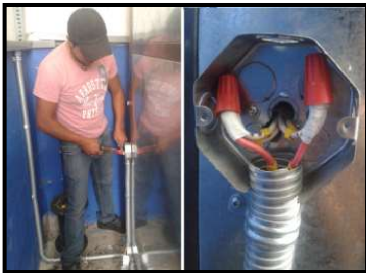
Figura 98. Conexiones de los conductores con aisladores
