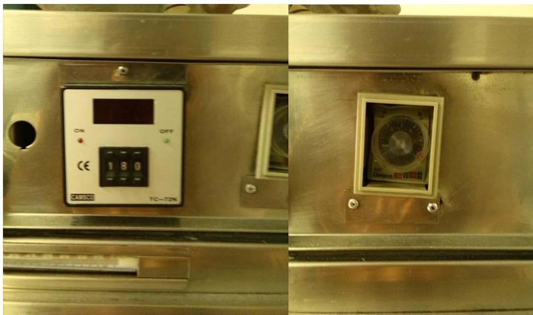
Figura 20 Visualizador y temporizador deteriorado
