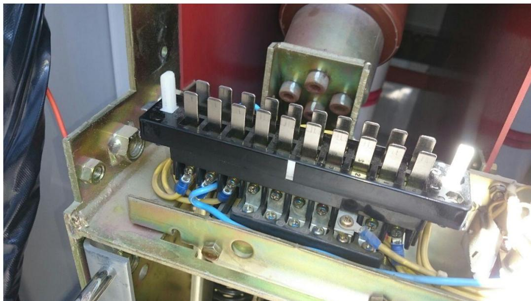
**Figura 99 Conexión de la señal del resorte**
