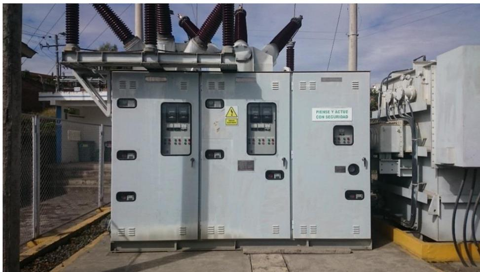
**Figura 81** Tablero de Control de las Líneas de 69kV.
