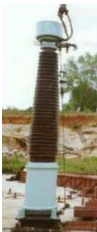
**Figura 6 Transformador de Corriente.**
