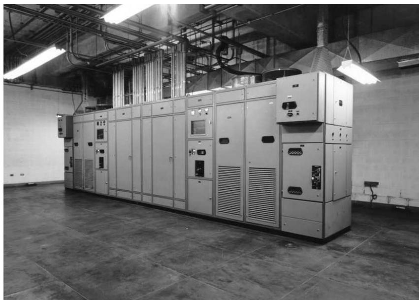
**Figura 3 Subestación Eléctrica Tipo Interior.**
