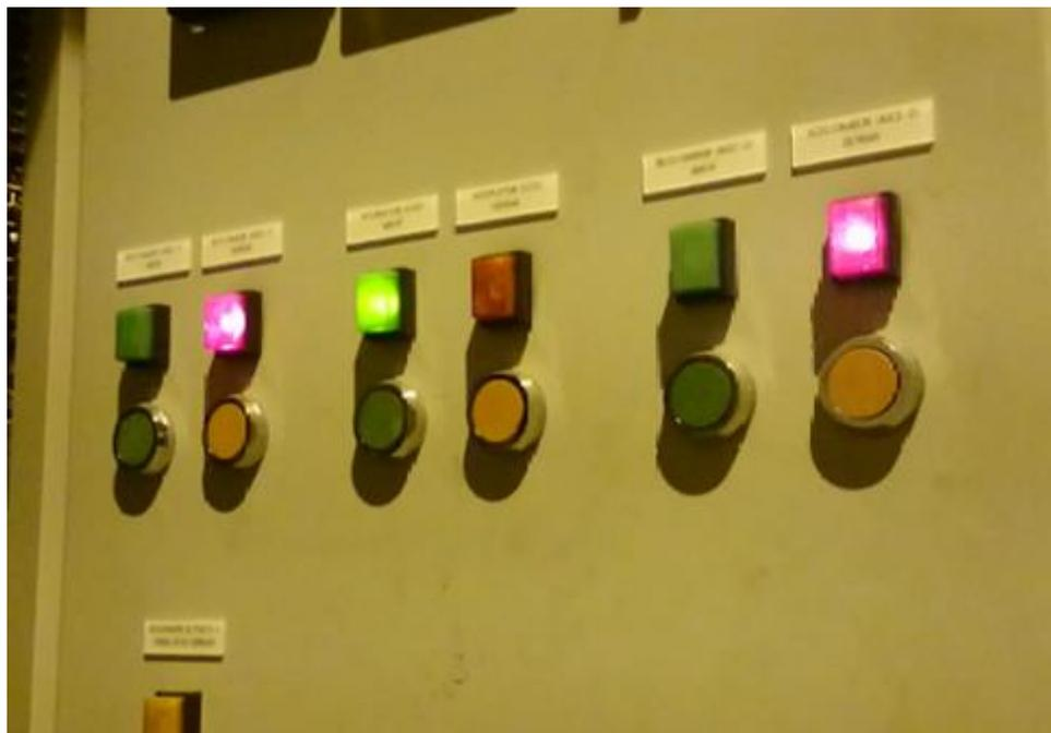
**Figura 118 Mando de cerrado en los seccionadores.**
