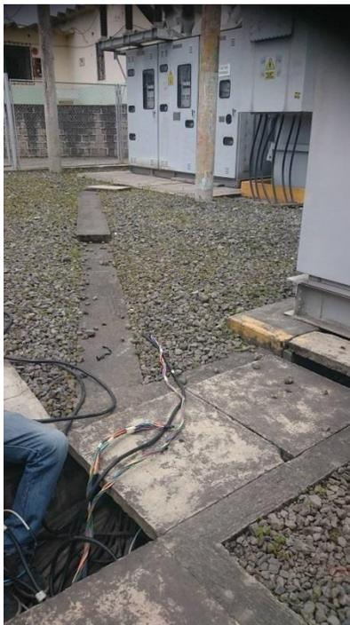
**Figura 93 Canaleta Subterránea para las Líneas de 69kV.**
