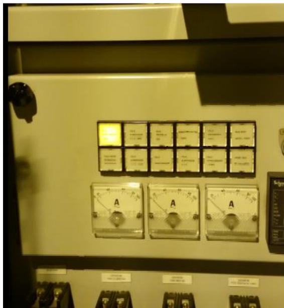
Figura 121 Activación Falla sobrecorriente Línea de 69kV.
