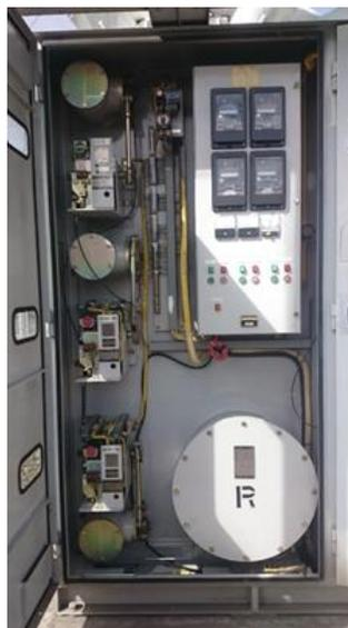
**Figura 82** Tablero de control ubicado en los gabinetes de las líneas de 69kV.
