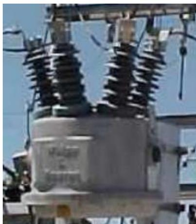
**Figura 7 Transformador de Tensión.**
