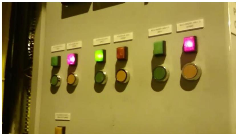
**Figura 124 Mando de apertura del disyuntor.**
