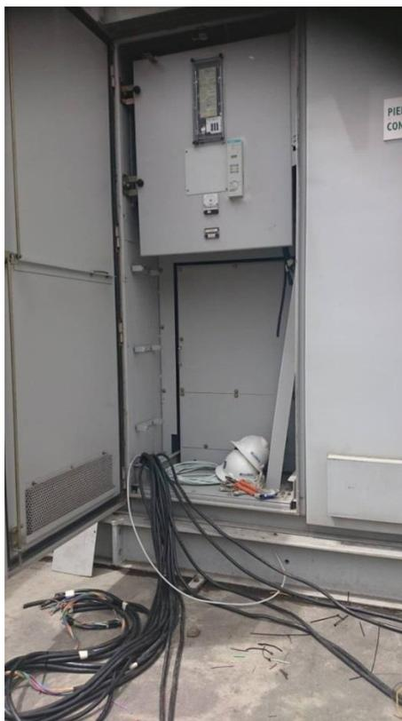
**Figura 92 Cableado de los gabinetes al tablero de barras.**
