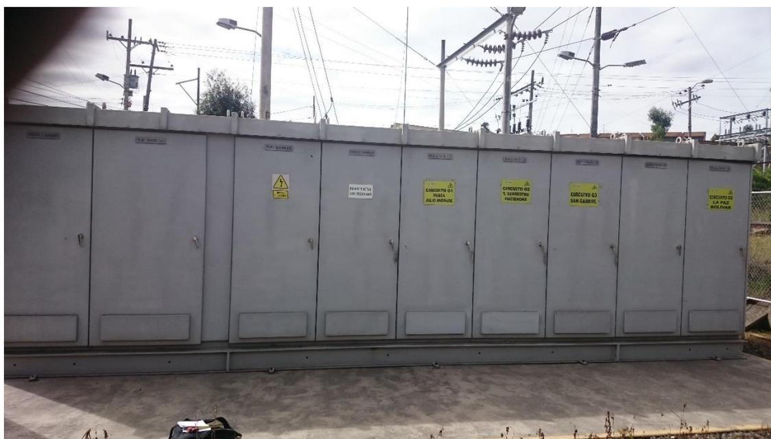
**Figura 75 Tableros de Control lado 13,8kV.**
