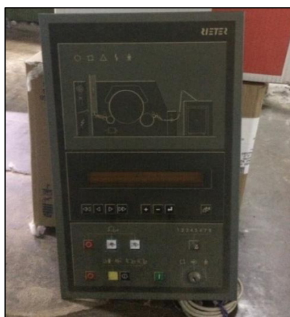
Figura 133 Panel del operador antiguo desmontado del tablero principal.
