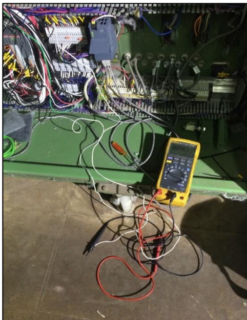
Figura 131 Medición de voltaje de alimentación antes de energizar el autómata.
