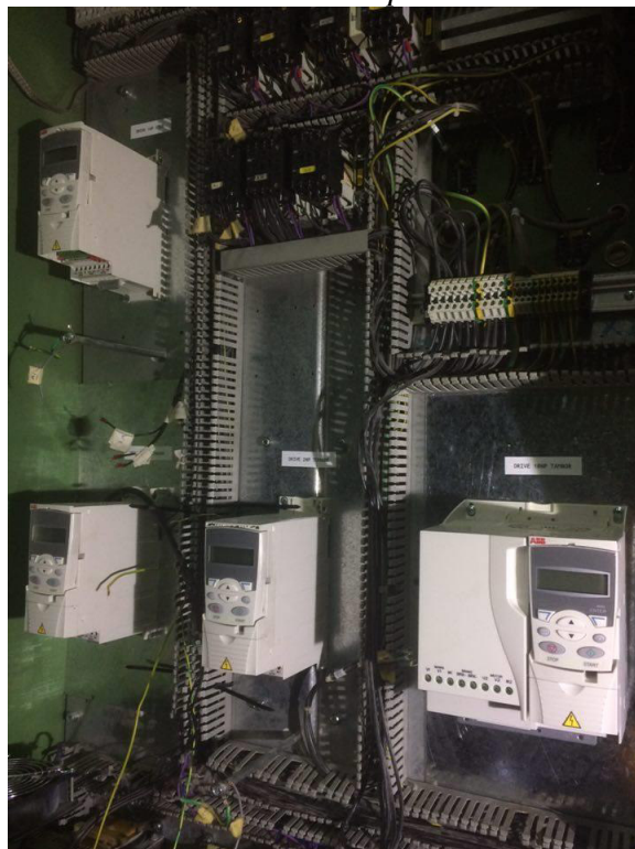
Figura 123 Variadores de frecuencia anteriores en el tablero principal Fuente: Propia
