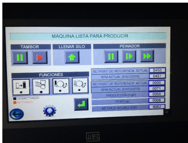
Figura 135 Pantalla HMI actual fijada al tablero principal.
