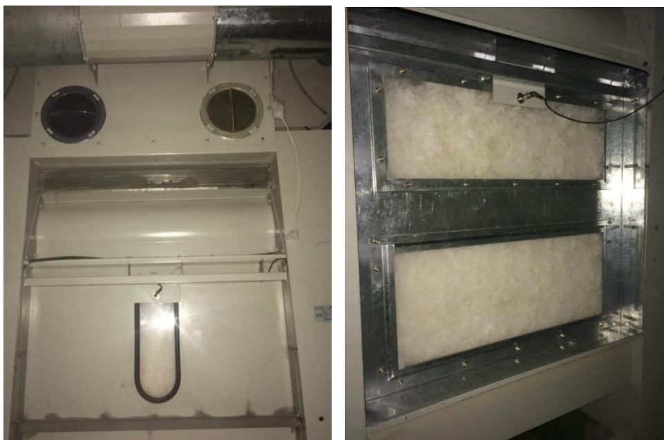
Figura 139 Izq. puerta anterior y Der. puerta actual instalada en el Silo
