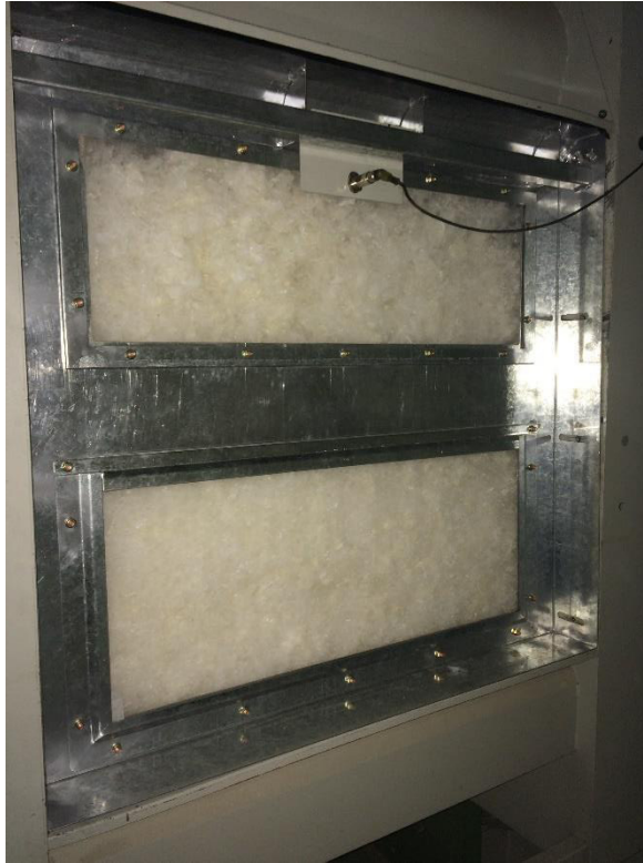
Figura 159 Material lleno en el compartimiento del Silo
