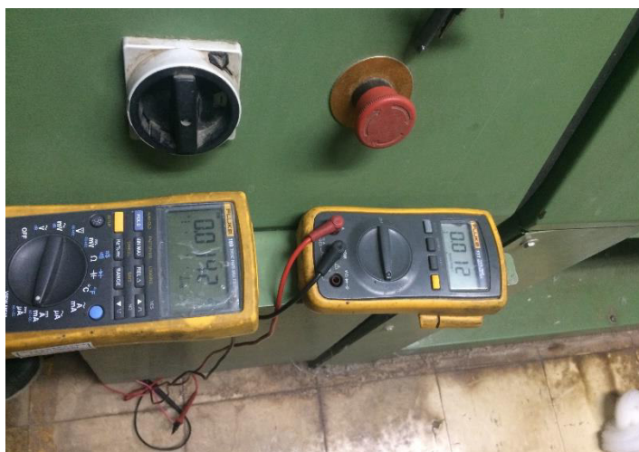
Figura 152 Prueba de medición en pulsadores e interruptores del tablero eléctrico
