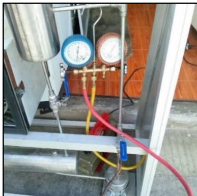
Figura 46: Conexión de bomba de vacío
