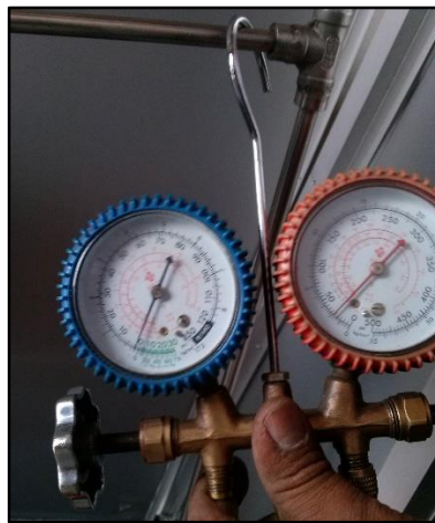
Figura 49: Instalación de los manómetros y mangueras en el sistema
