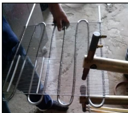
Figura 40: Fijación de varillas al condensador de tubos y aletas
