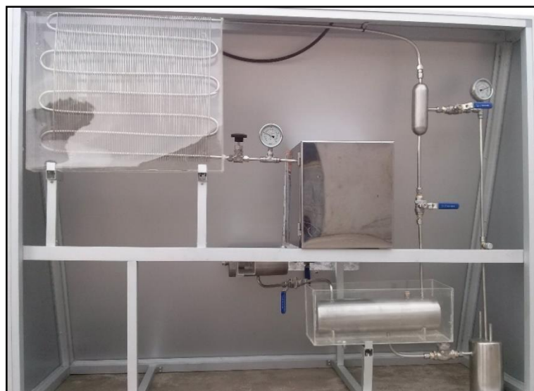
Figura 29: Válvulas de control instaladas en el sistema de refrigeración
