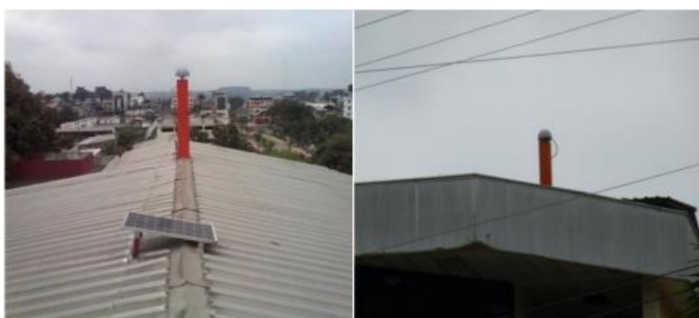
Figura 8.- Estación de Monitoreo Continuo QVEC.
