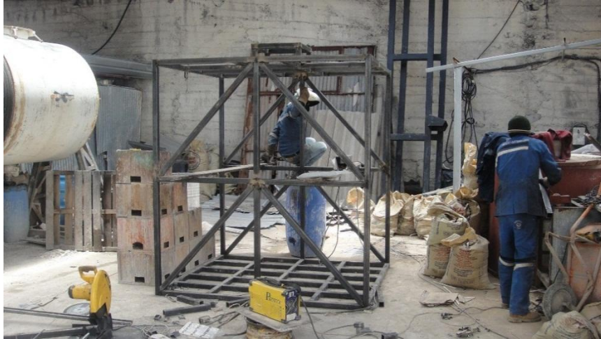
Figura 95 Cabina en fases finales de construcción
