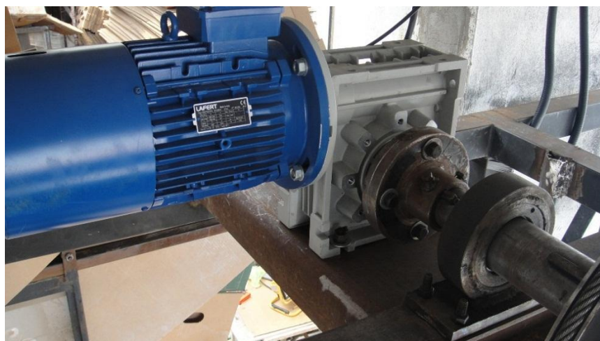
Figura 100 Instalación de sistema transferidor de movimiento
