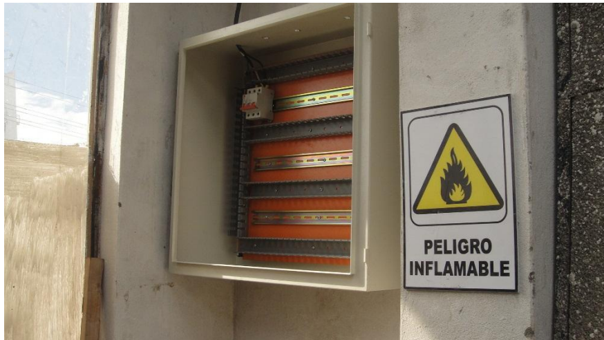
Figura 104 Instalación de elementos de potencia
