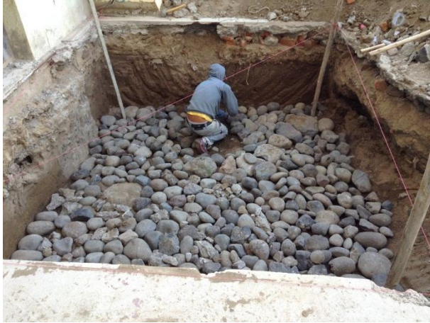
Figura 87 Hueco de la fosa y endurecimiento del piso
