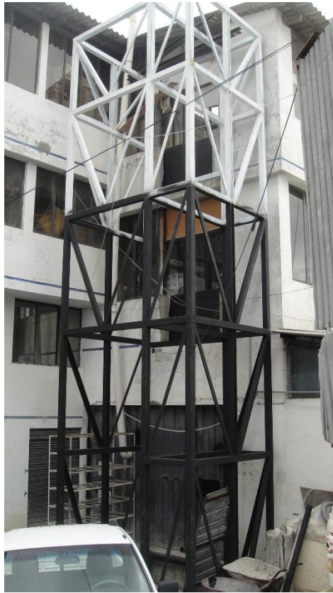
Figura 93 Estructura terminada, ducto principal y ducto secundario
