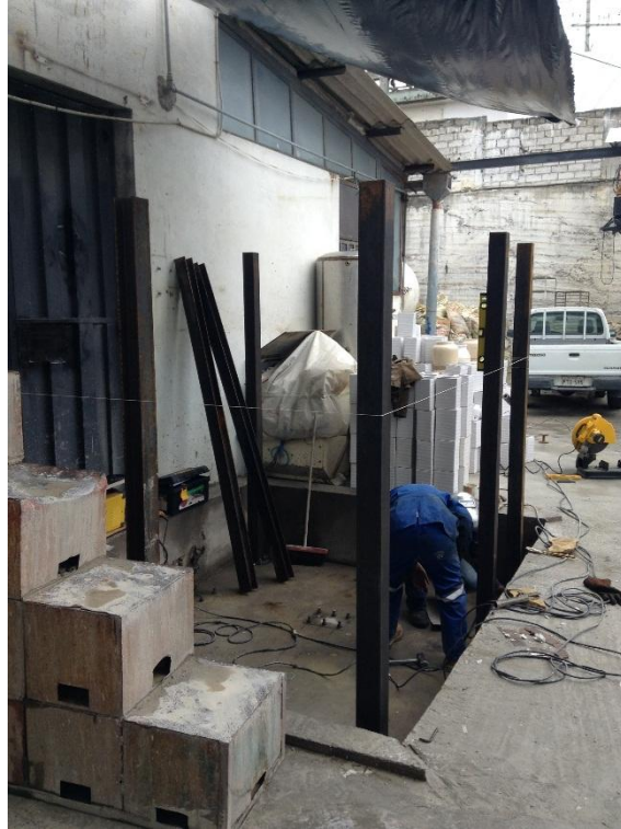
Figura 91 Colocación de las columnas
