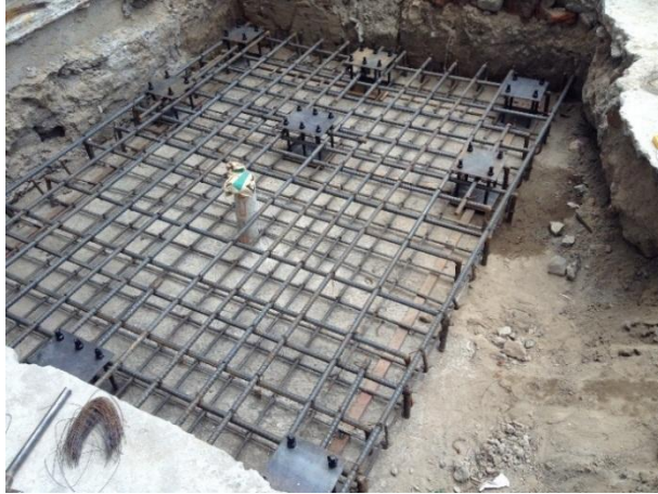
Figura 89 Amarre de la varilla y posicionamiento de las placas base
