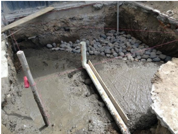
Figura 87 Hueco de la fosa y endurecimiento del piso
