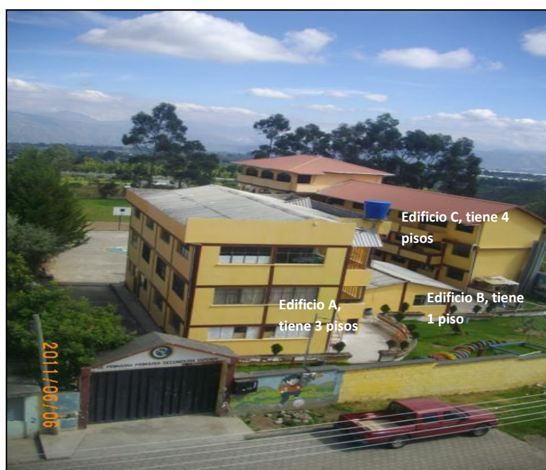
Figura 32. Fotografía de los edificios del colegio
