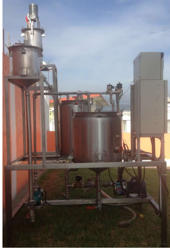
Figura 85 Estructura metálica del bastidor
