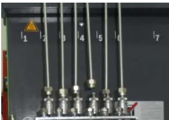
Figura 179. Colocación de cañerías
