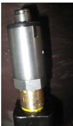
Figura 55 Instalación del Transductor Turck (PT500).
