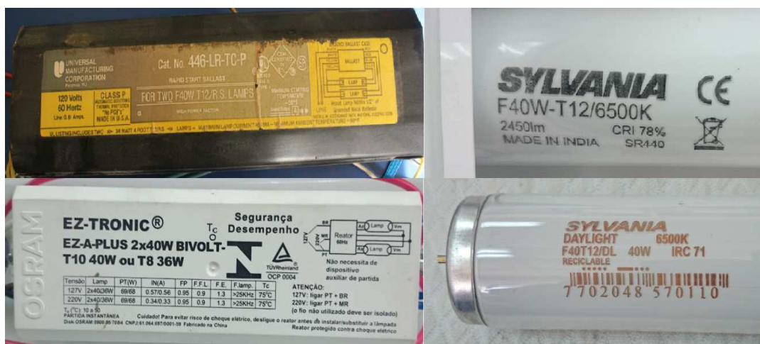
Figura 33 Balastro electromagnético y electrónico del Hospital
