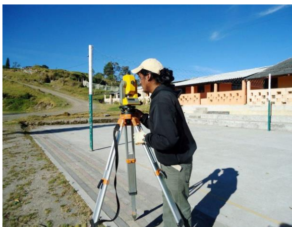
Figura 10: Levantamiento topográfico con estación total.
