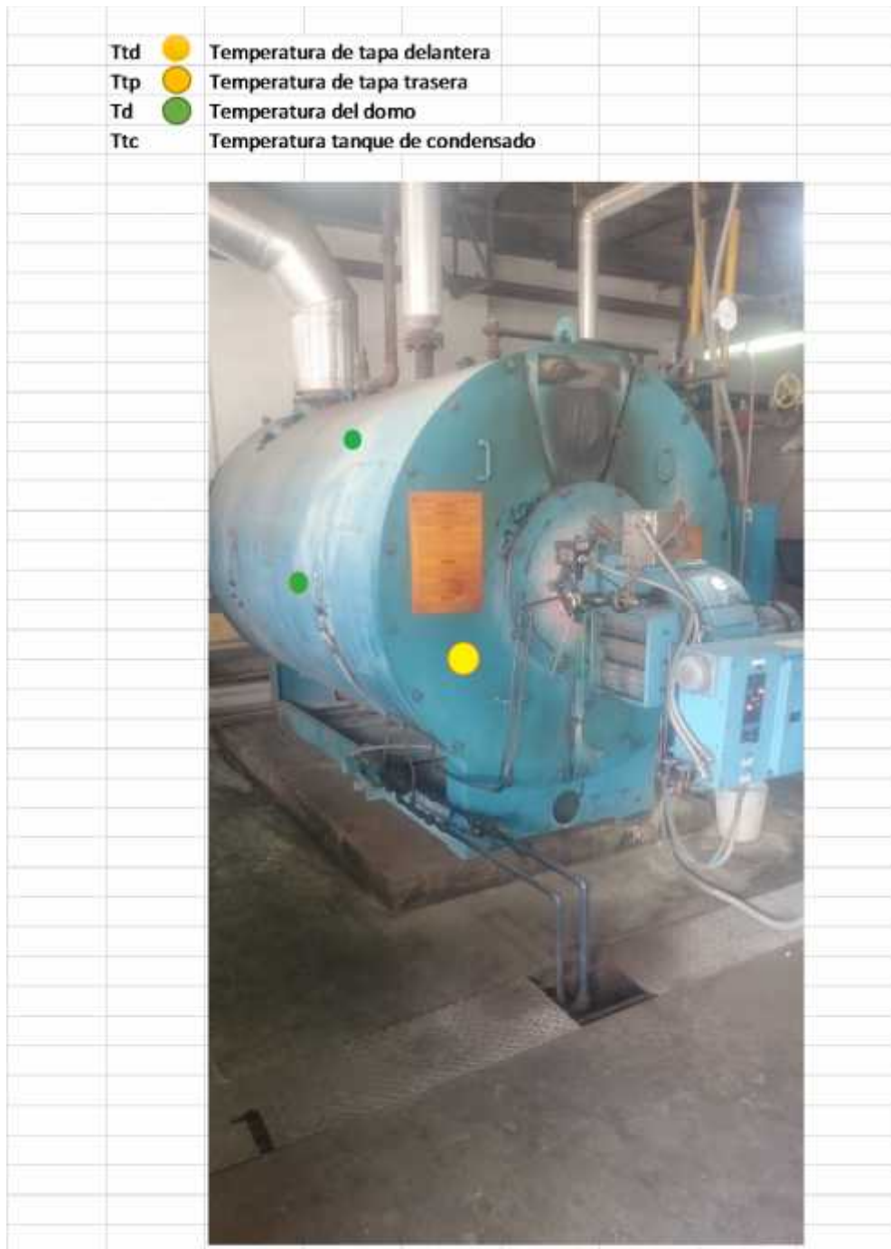
Figura 22: Esquema de medición de temperatura
