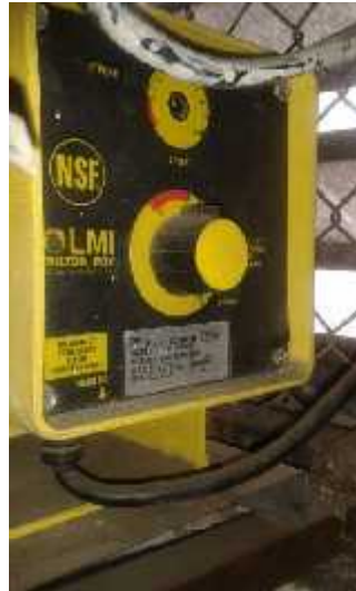
Figura 19: Bombas de alimentación de químicos al caldero
