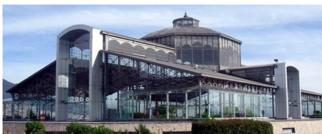
Figura 24 Centro Cultural Itchimbia Fuente: (Gerencia de PhotoCrawler, 2013)
