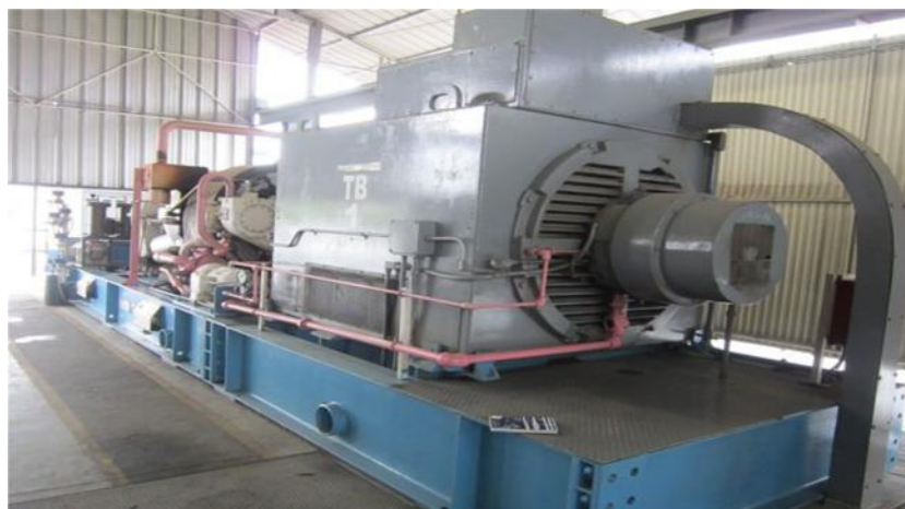
Figura 24 Turbina TB1 de 1750 MW
