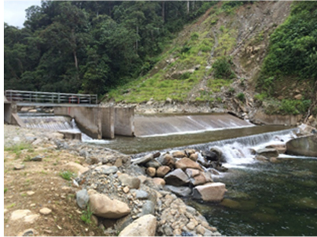
Figura 12: Obras de Captación
