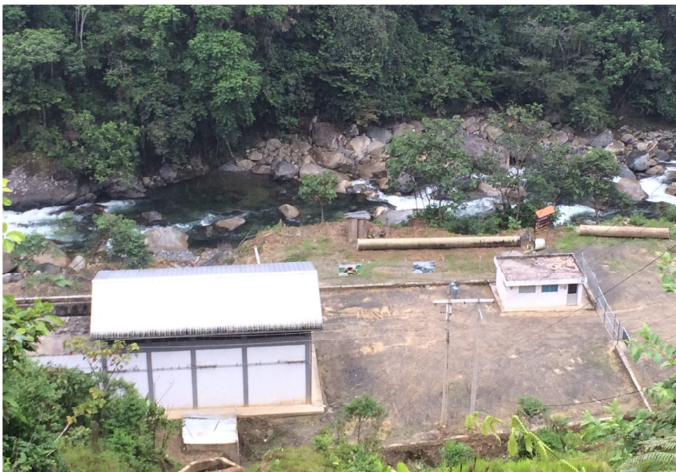
Figura 15: Casa de Máquinas
