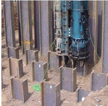
**Figura 4 Pilotes de acero formados por perfiles I**
