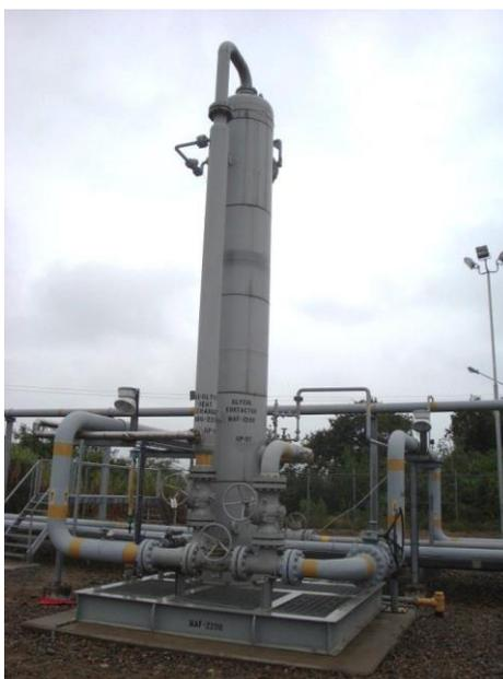
Figura 7 Torre Contactora
