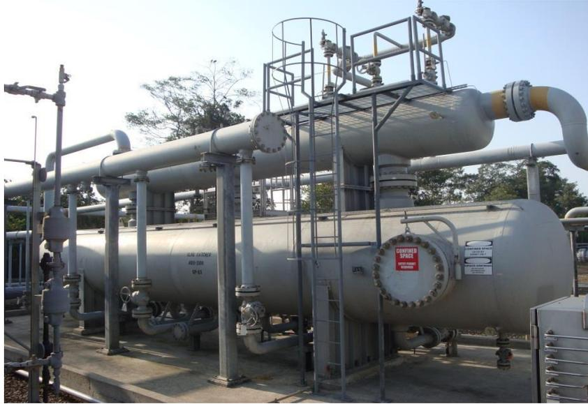
Figura 5 Separador de Gas y Condensados.
