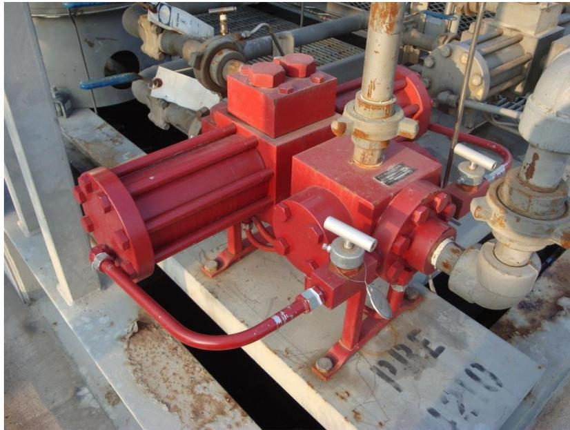
Figura 14 Bombas de glicol de intercambio de energía.
