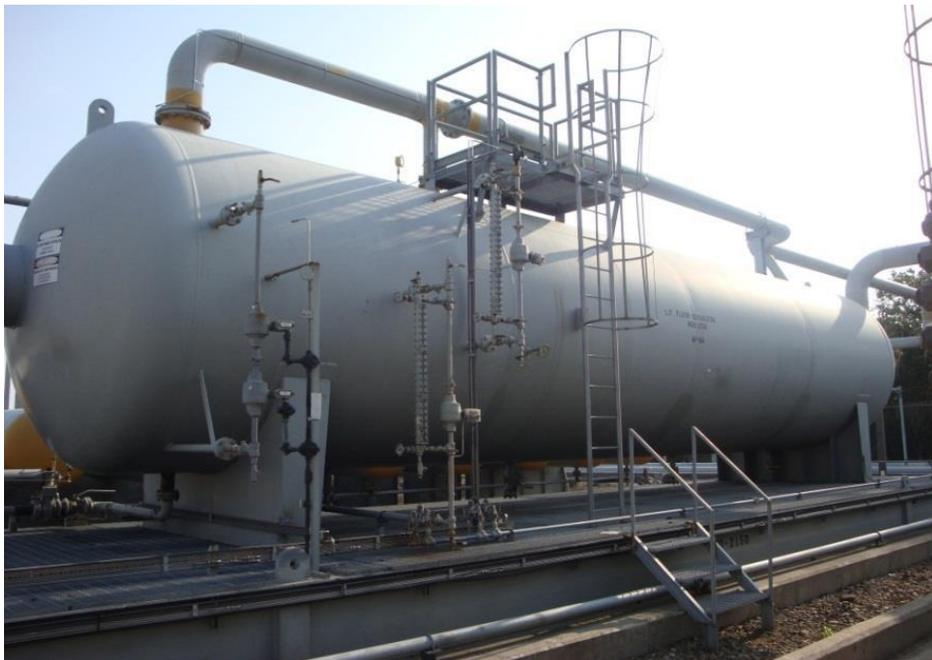
Figura 6 Separador Flash de condensados
