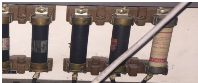
Figura 22 Fusibles para solenoides máquina Van Dorn.
