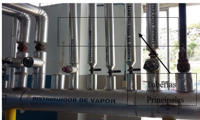
**Figura 5. Tuberías principales**
