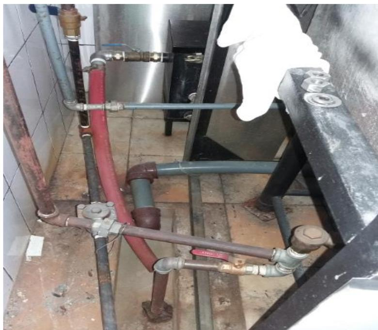
**Figura 6 Ramal de ingreso de vapor a la autoclave.**
