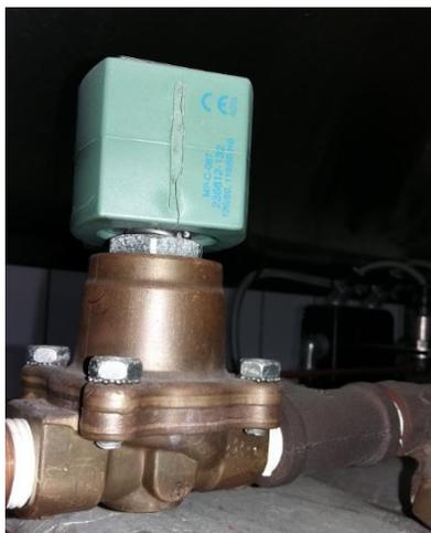
**Figura 39** Válvula (dañada) de paso de vapor de la camisa a la cámara
