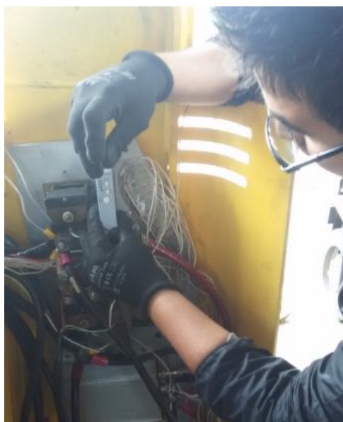
Figura 87. Instalación de Temporizador WEG modelo ERWT
