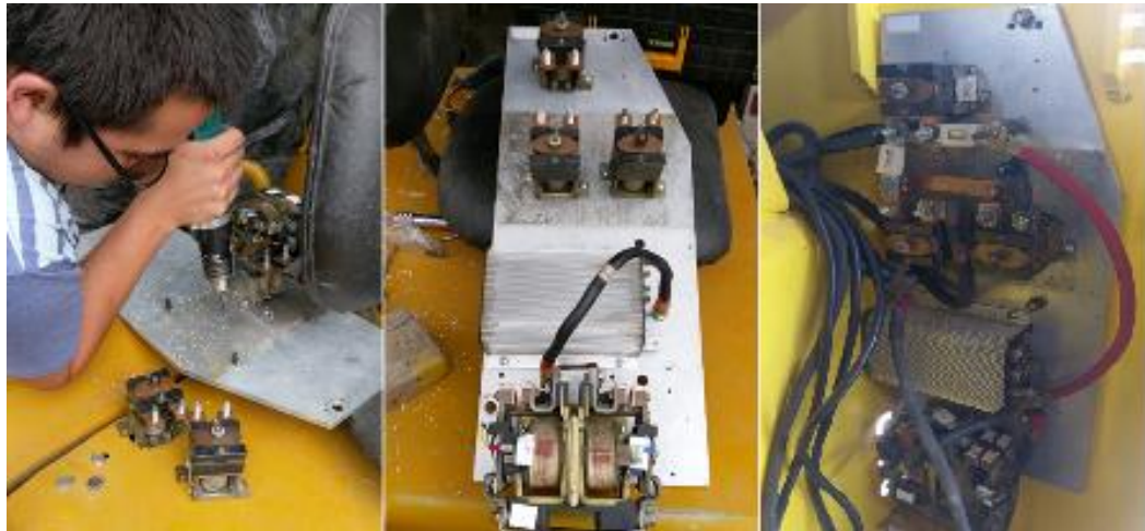
Figura 90 Instalación eléctrica de potencia
