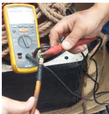
Figura 72 Prueba de aislamiento de motor
