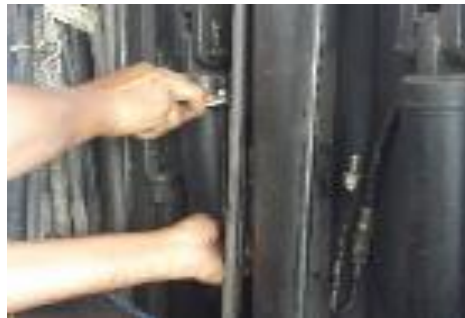
Figura 73 Instalación de Pistón
