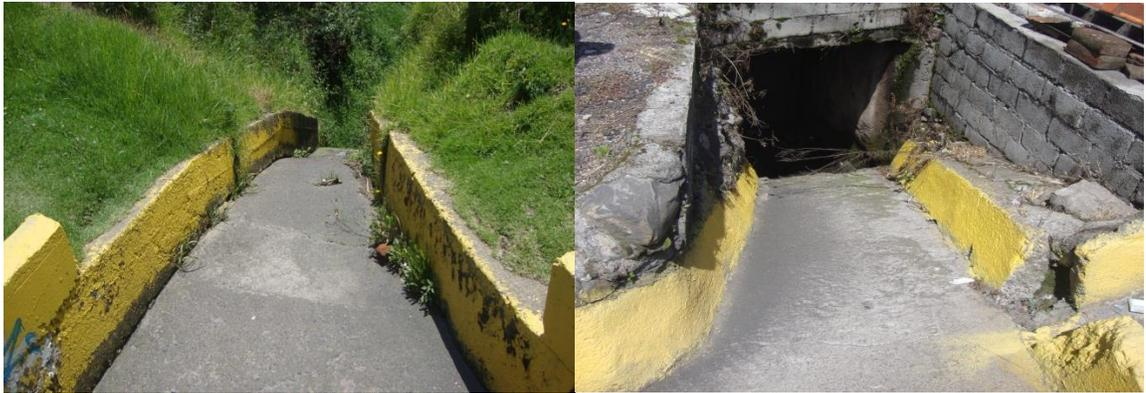
**Figura 114.** Desfogues de cunetas laterales a quebradas o alcantarillas
