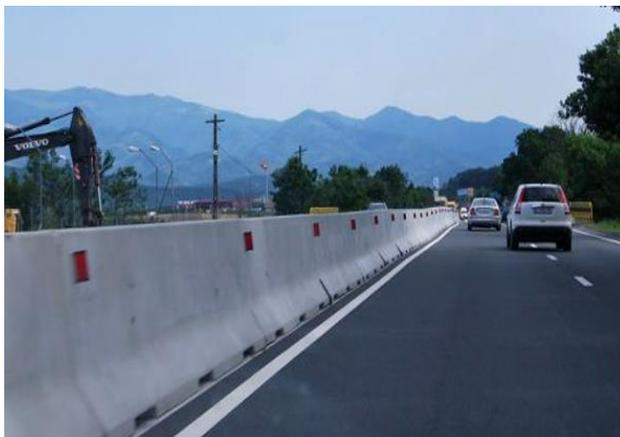
**Figura 137.** Protección maciza de hormigón
