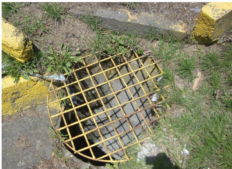
**Figura 112.** Entrada de Alcantarilla circular
