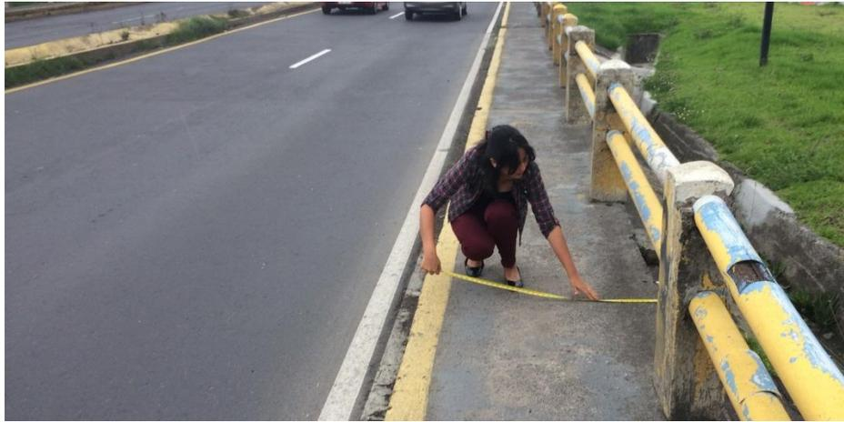
**Figura 103.** Ancho (1.20m) de la vereda del puente sobre el río San Pedro.
