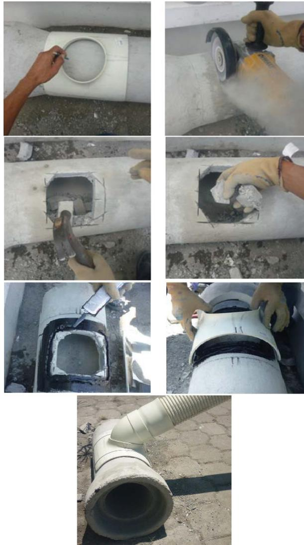
**Figura 26: Detalle de colocación de la silla**
