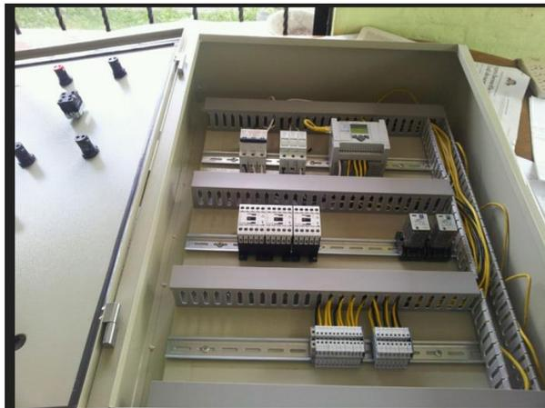
**Figura 113. Conexiones entre elemntos del tablero.**
