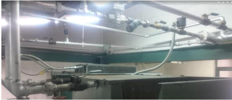
Figura 122. Cableado de la electroválvula de la secadora verde.
