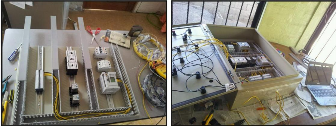
**Figura 112. Conexion entre elementos del tablero.**
