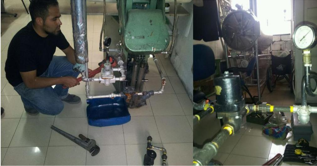
Figura 117. Montaje de la electroválvula.
