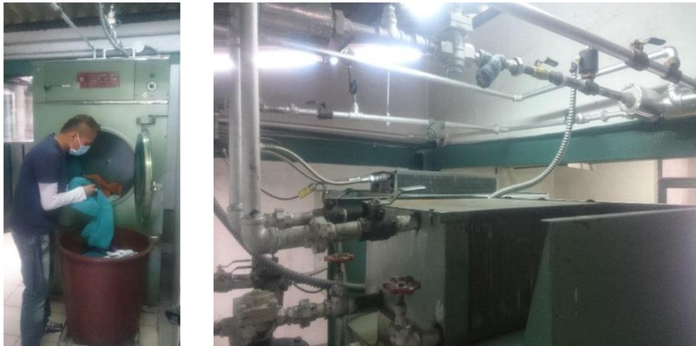
Figura 50. Secadora de ropa con sus conexiones de vapor.
