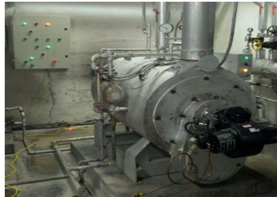
Figura 150. Tablero de control en caldera.
