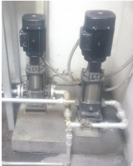
Figura 47. Bombas Centrífugas verticales CRT.
