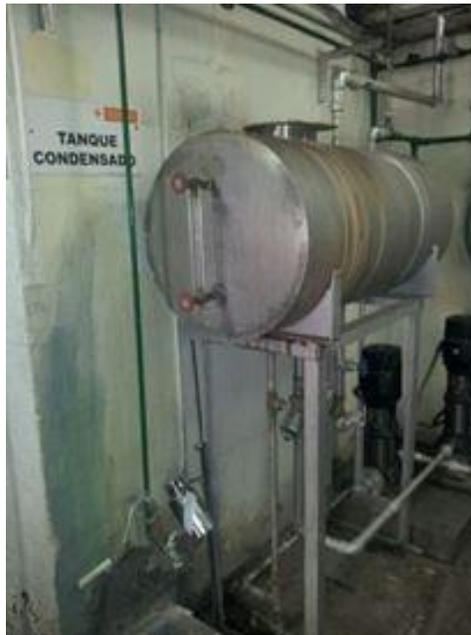
Figura 43. Tanque de condensado de NOVA CLIICA.
