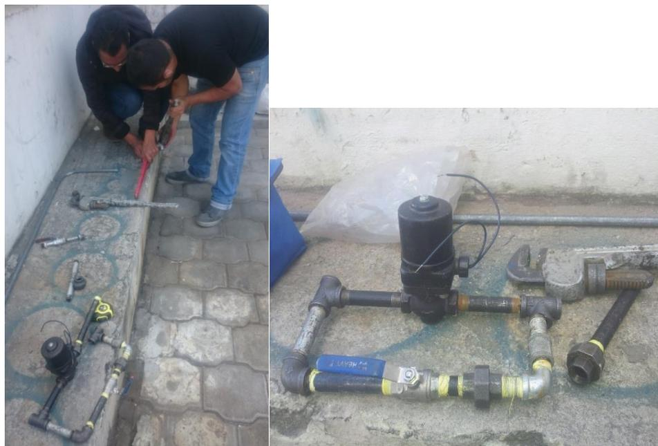
Figura 116. Conexion de la electrovalvula con Bypass.
