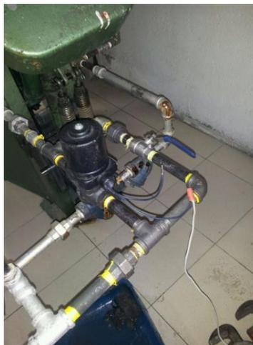
Figura 118. Cableado de la electroválvula.
