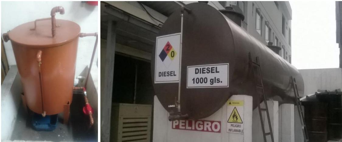
Figura 18. Tanque primario y secundario de diesel.
