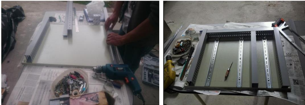
**Figura 106. Bandeja del tablero electrico con canaletas y riel.**
