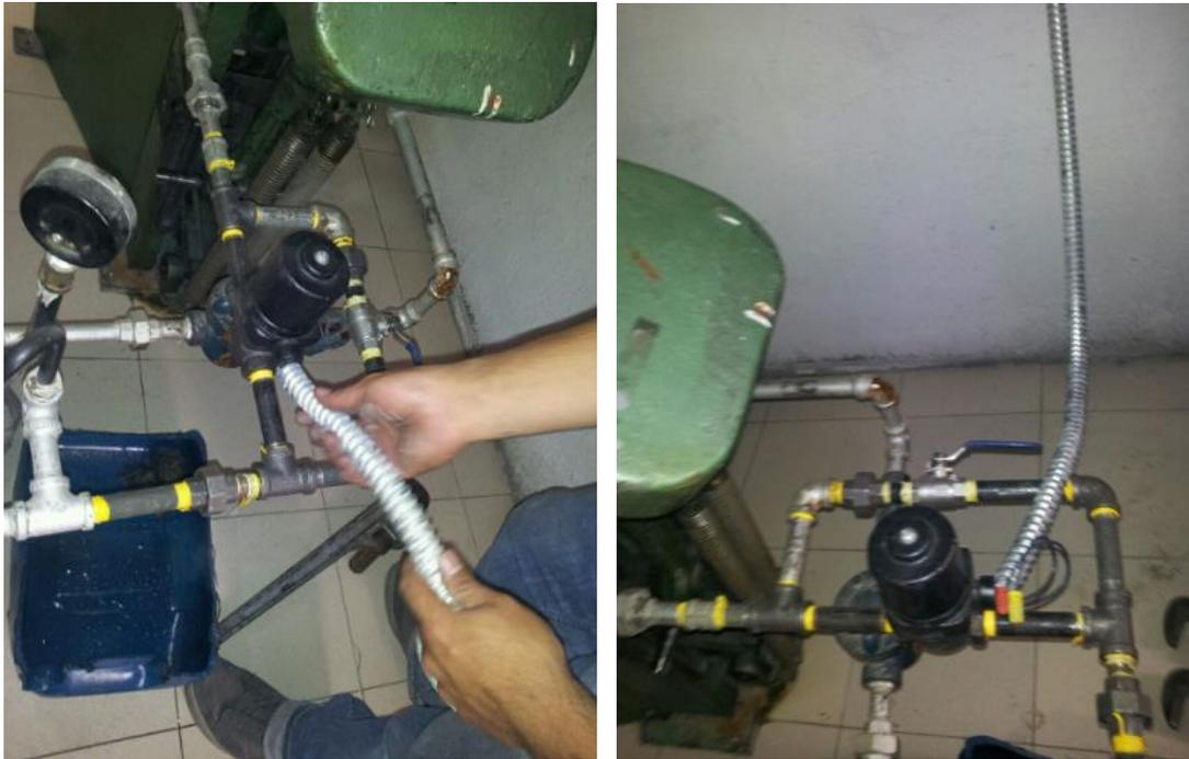
**Figura 119. Incorporación elemento de protección.**
