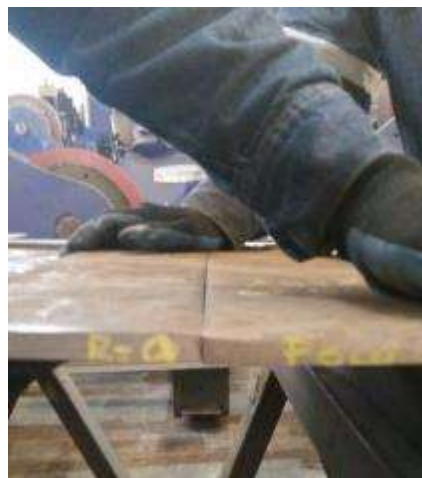
Figura 44 Verificación de desalineación en la preparación de las planchas
