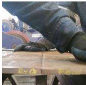
Figura 16 Chequeo de la alineación antes de soportar sobre la máquina herramienta
