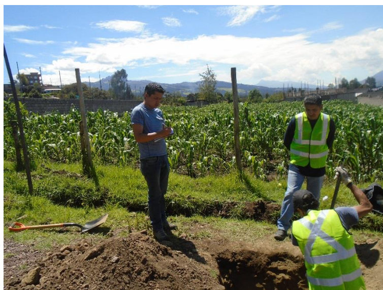
Figura 4 Excavación de calicata
