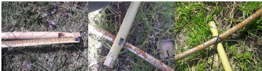
Figura 83: Destaje y detalle de ensamblaje de elementos verticales con abrazaderas al anillo
