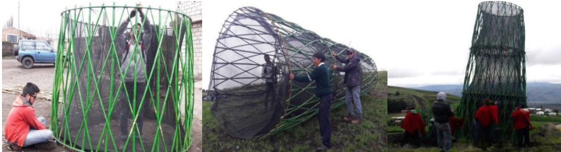
Figura 87: Colocación de malla y ensamblaje de módulos superiores
