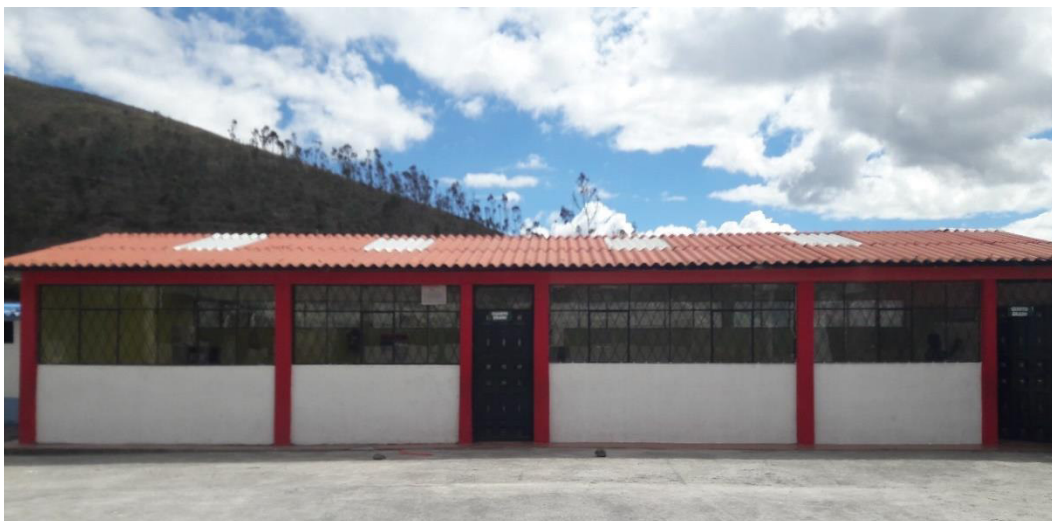
Figura 43: Vista frontal del bloque 1 de la Escuela
