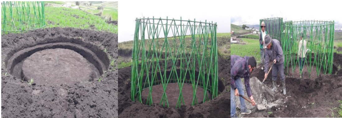
Figura 86: Empotramiento del módulo base
