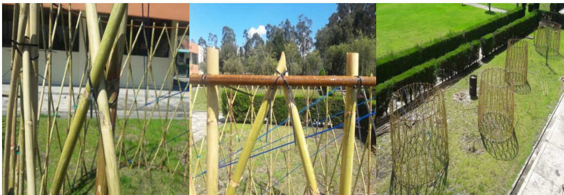
Figura 85: Colocación de diagonales y detalle de amarre
