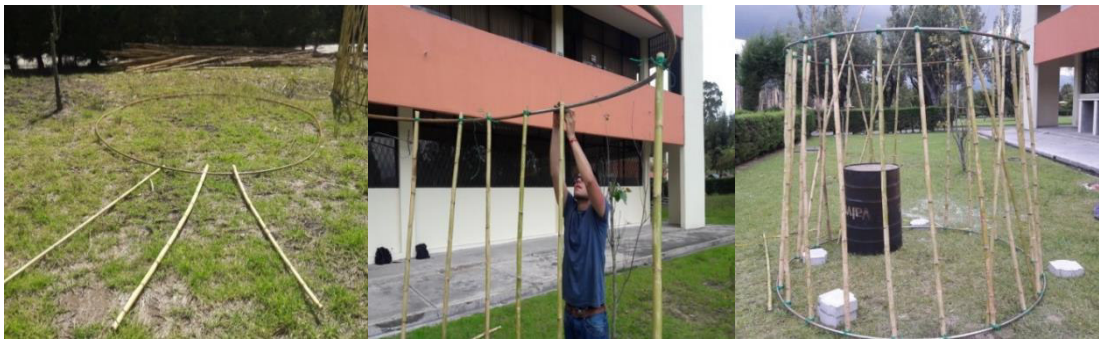
Figura 84: Procedimiento para elevar un módulo
