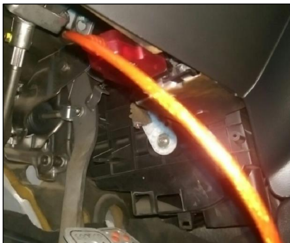
Figura 60 conexión PC y unidad de control
