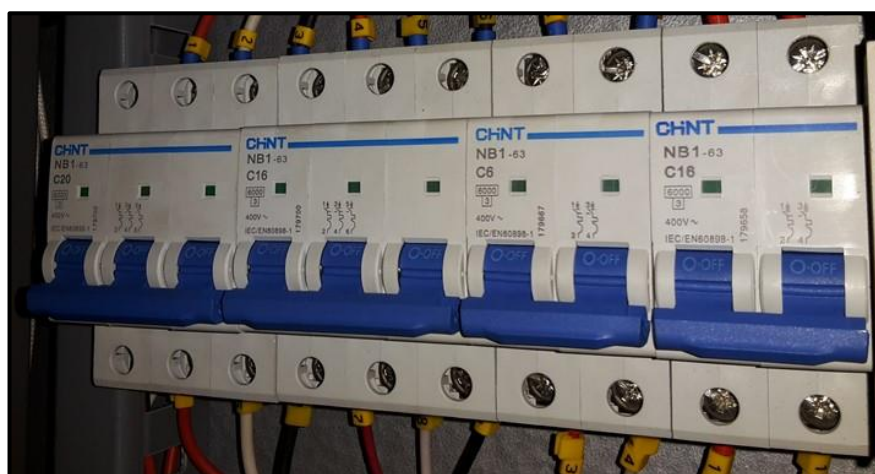
Figura 29. Interruptor magnetotérmico
