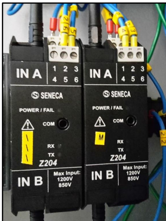
Figura 31. Sensor de voltaje Z204
