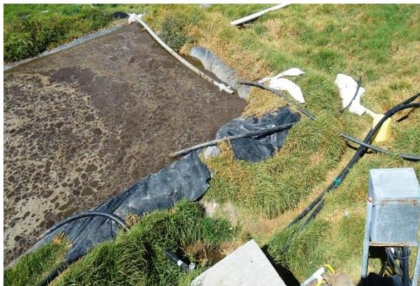
**Figura 17** Secado de Lodos para uso Agrícola
