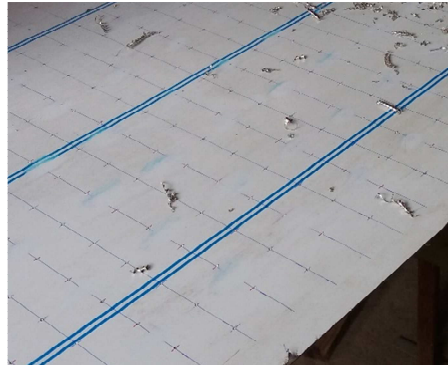
Figura 46 Marcación sitios a perforar
