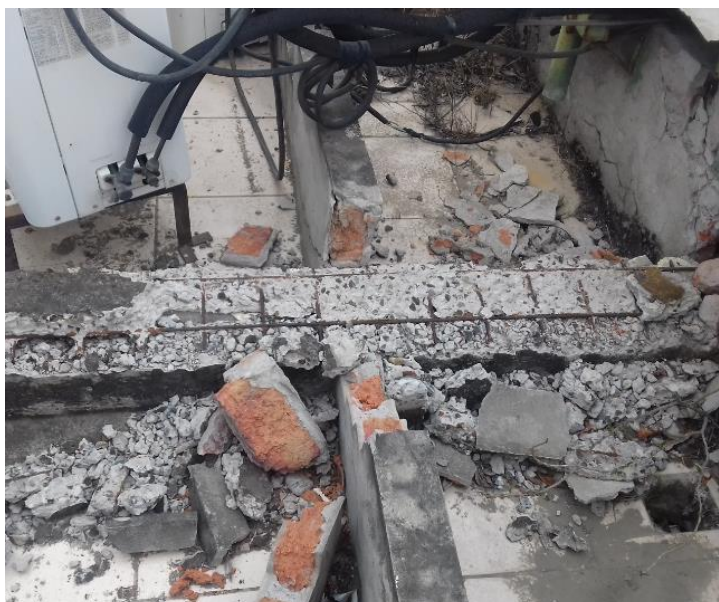
Figura. 6. Vigas colapsadas
