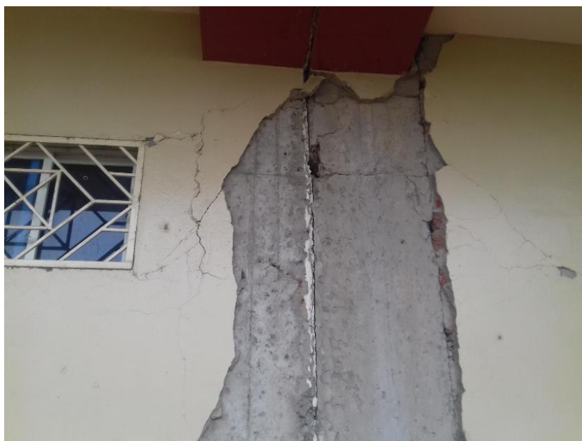
Figura. 2. Junta de Construcción
