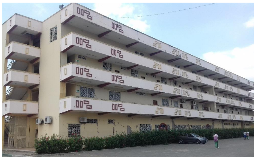
Figura. 1. Vista Frontal del Edificio
