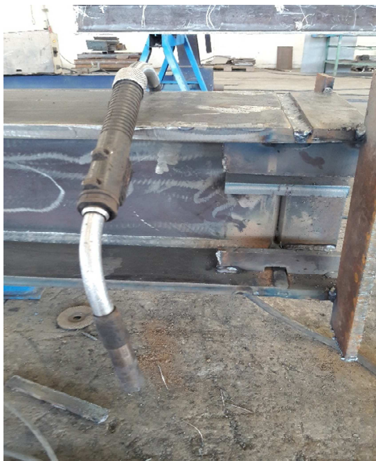
Figura 153: Soldadura FCAW vigas del hospital de Ambato
