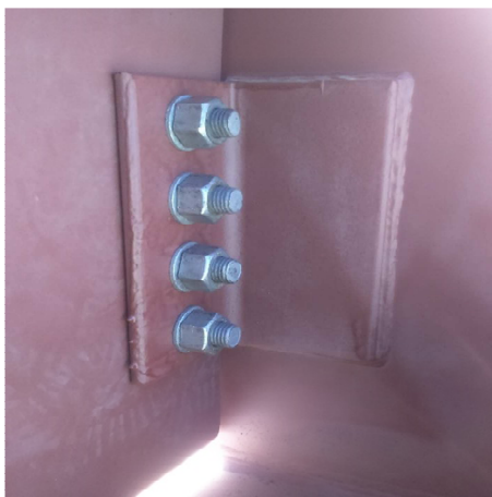
Figura 134 : Conexión apernada y soldada con placa
