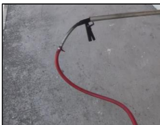
Figura 77: Sonda dentro del tubo de escape.
