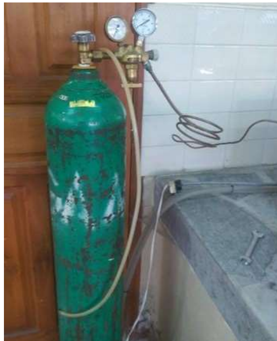
Figura 34: Colocación de oxígeno
