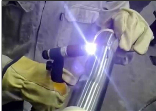
Figura 38 Soldadura de las piezas de la estructura (Proceso TIG).
