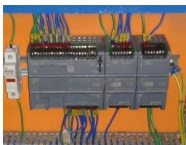
**Figura 91. Implementación del PLC y módulos**
