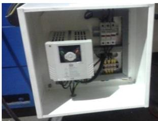
**Figura 93. Tablero eléctrico del variador de frecuencia del motor de la sierra**
