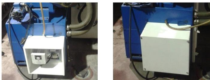
**Figura 80. Tablero eléctrico del variador de frecuencia**
