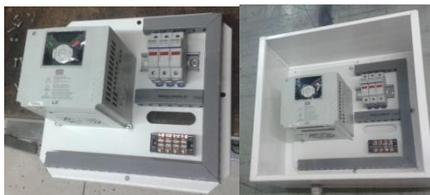
**Figura 89. Montaje de componentes del tablero del variador de frecuencia**
