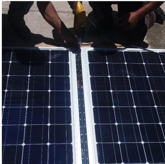
**Figura 48.** Ensamble paneles, perfiles y bisagra.
