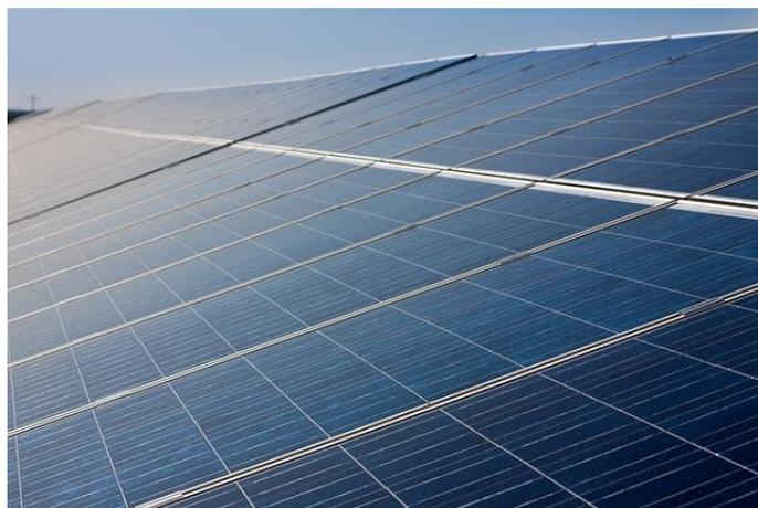
**Figura 6.** Panel solar fotovoltaico policristalino.
