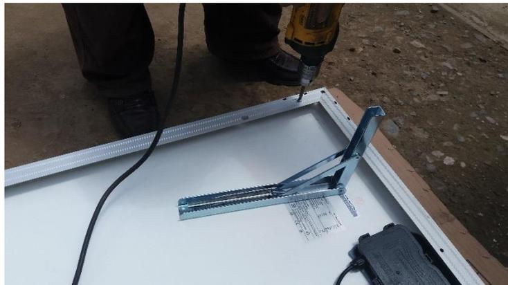
**Figura 50.** Ubicación de una base sobre el panel solar
