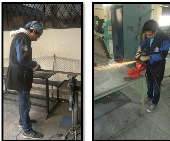
Figura 198. Pulido del ángulo de acople de columnas
