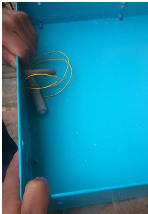
**Figura 106: Instalación del sensor de nivel en la bandeja de agua**
