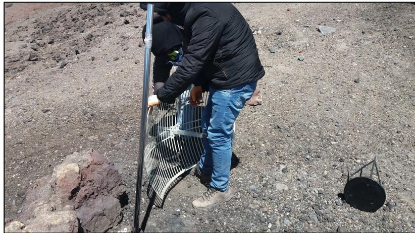
**Figura 30: Instalación del mástil y la antena**
