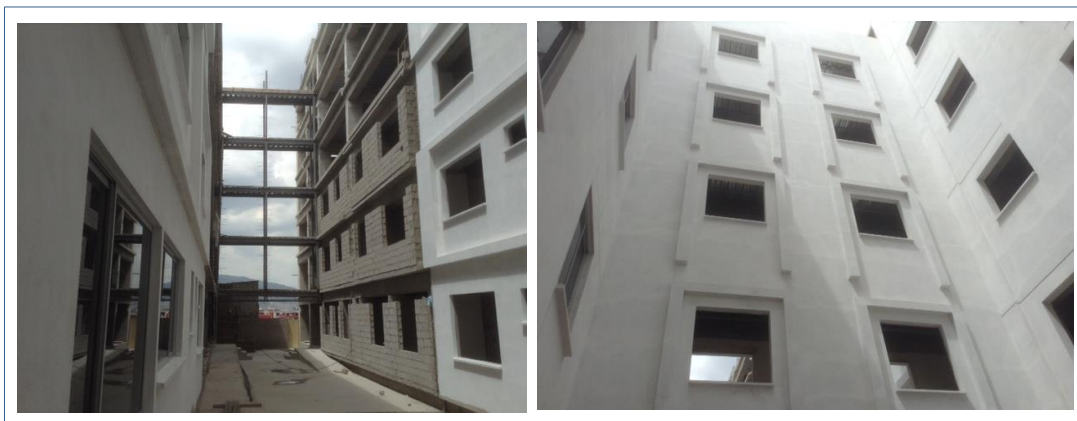
Figura B2. Constructora INMOSECON, sistema constructivo mixto
