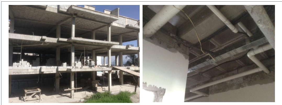
Figura B4. Constructora Saud, sistema constructivo tradicional
