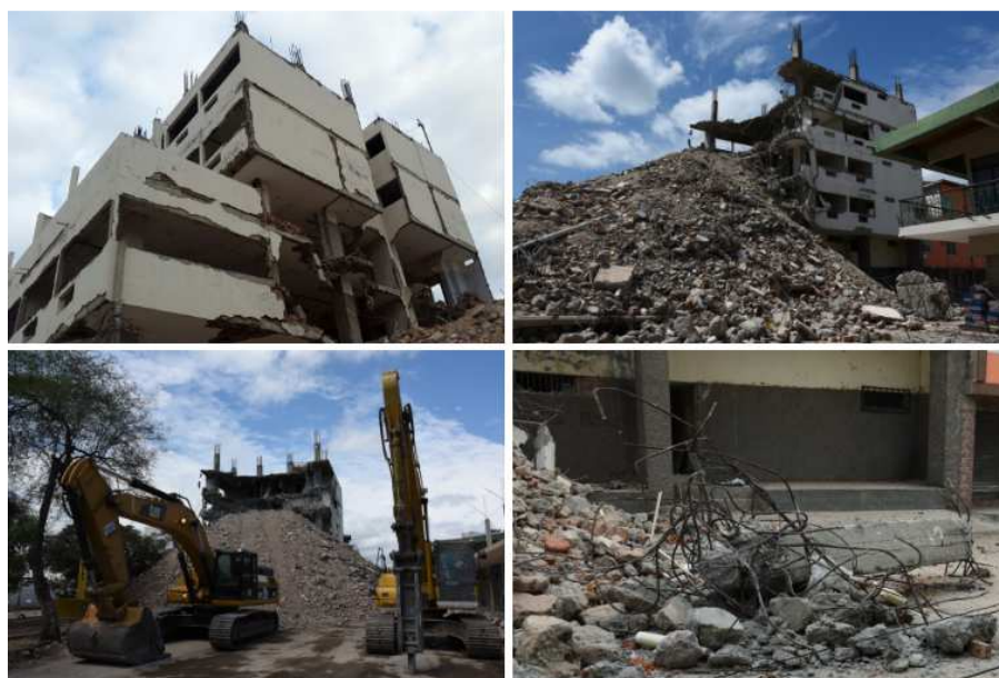
Figura 28 Extracción de la probeta tipo columna de hormigón armado, Manabí
