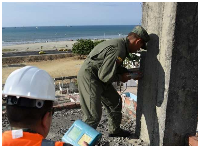
Figura 27 Verificación de la resistencia del hormigón en probeta, Manabí
