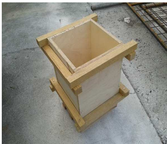
Figura 37 Encofrado de madera para probetas piloto de hormigón armado
