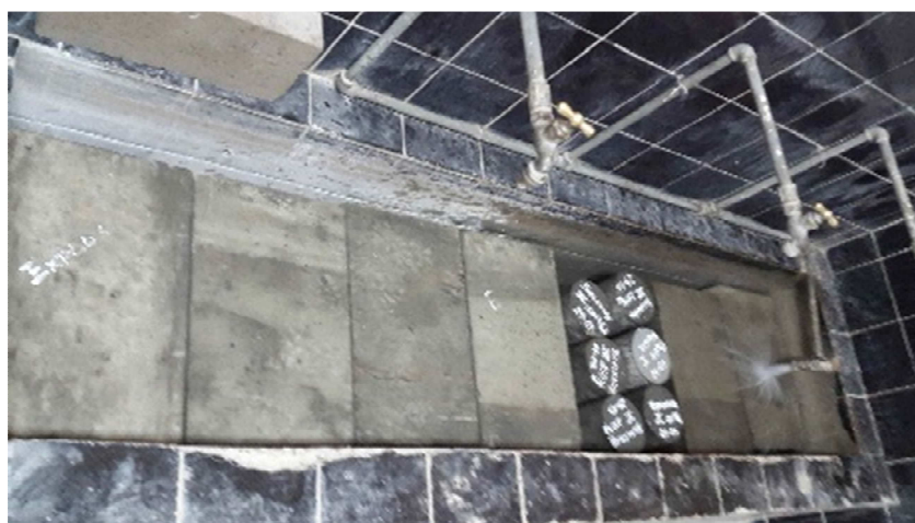
Figura 41 Piscina de curado para probetas piloto y cilindros de hormigón.
